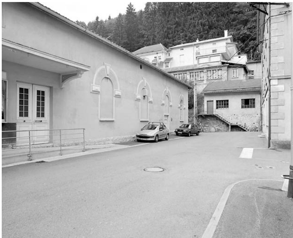
Élévation antérieure, de trois quarts gauche.
