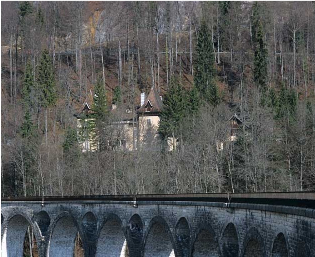
Vue d'ensemble rapprochée, depuis le sud-est.
