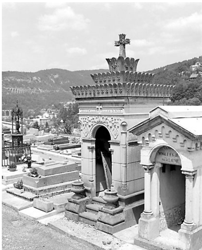
Façades antérieure et latérale droite.
