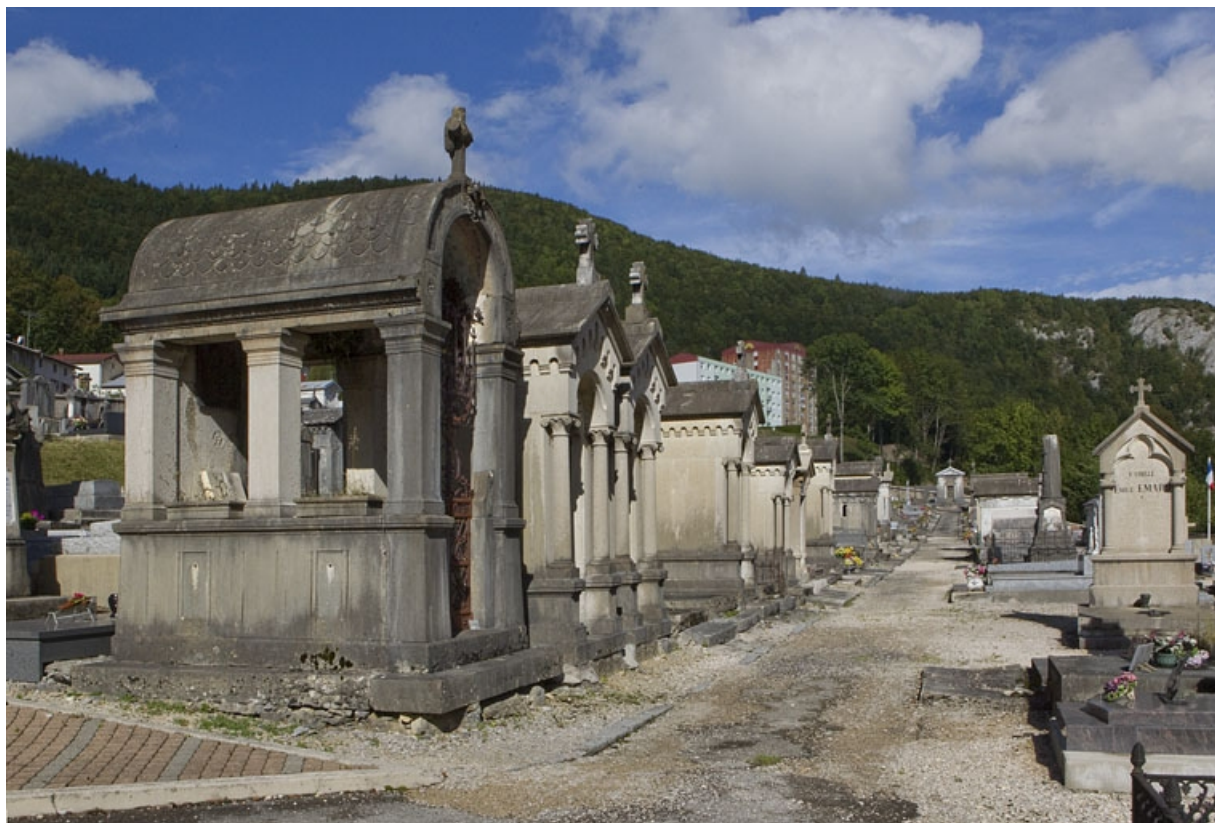
Tombeaux et chapelles funéraires du quartier 3, bordant l'allée le séparant du quartier 4 (à droite). 39, Morez, 10 allée du 3 Septembre
