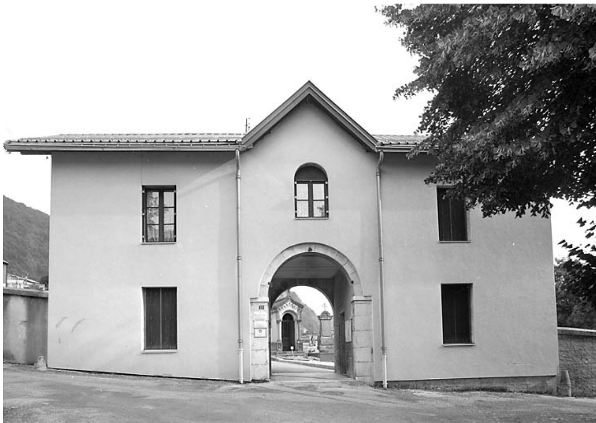
Pavillon d'entrée (conciergerie et logement).
