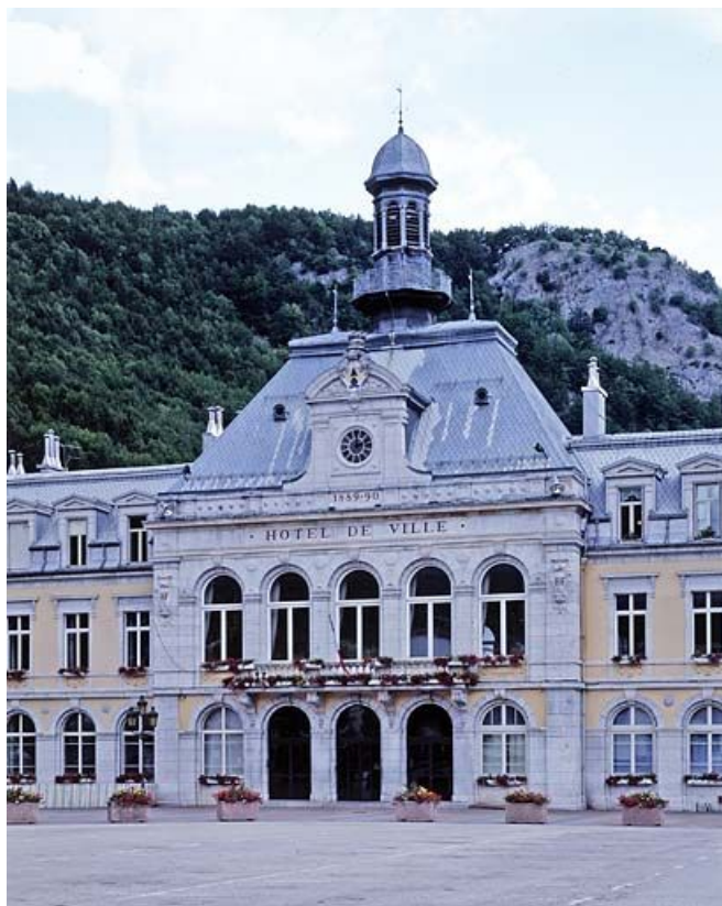
Élévation antérieure : pavillon central.
