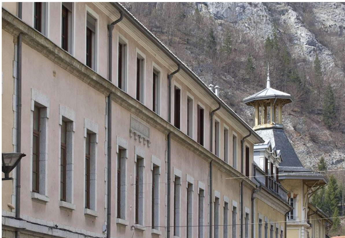
Aile latérale droite (école des garçons) : la surélévation.
