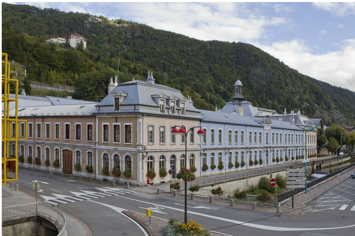
Vue d'ensemble, depuis le nord-ouest : élévations postérieure et latérale gauche. 39, Morez place Jean Jaurès
