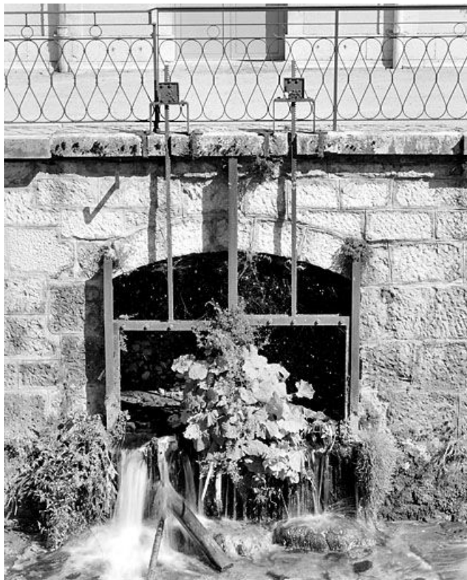
Aile latérale gauche : détail d'une prise d'eau du canal d'amenée passant sous le bâtiment. 39, Morez place Jean Jaurès
