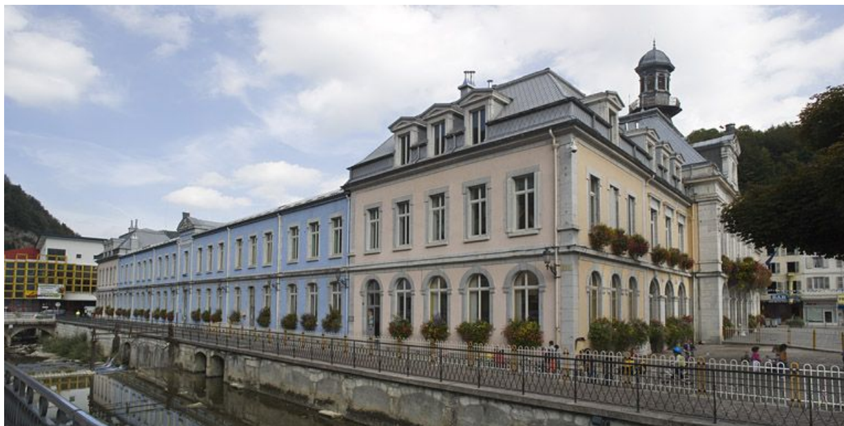
Vue d'ensemble, depuis le sud-ouest : élévations antérieure et latérale gauche. 39, Morez place Jean Jaurès
