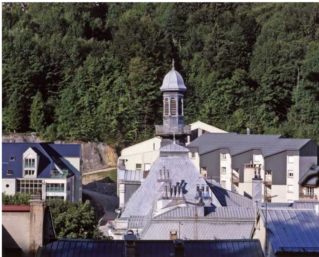
Campanile du pavillon central, vu de profil (nord-est).
