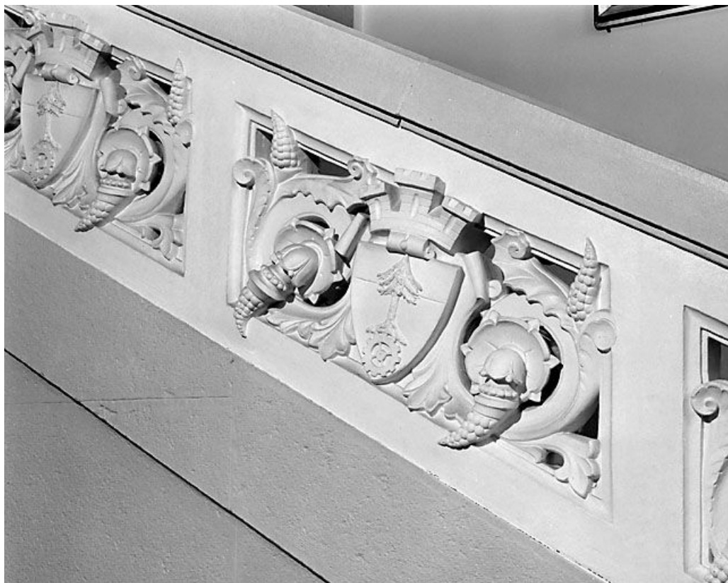
Escalier d'honneur : armoiries de la ville décorant le garde-corps.
