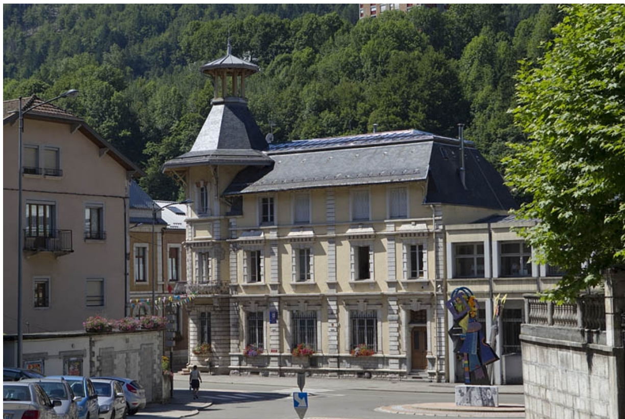
Vue d'ensemble, depuis l'avenue Charles de Gaulle (nord-est). 39, Morez, 108 rue de la République
