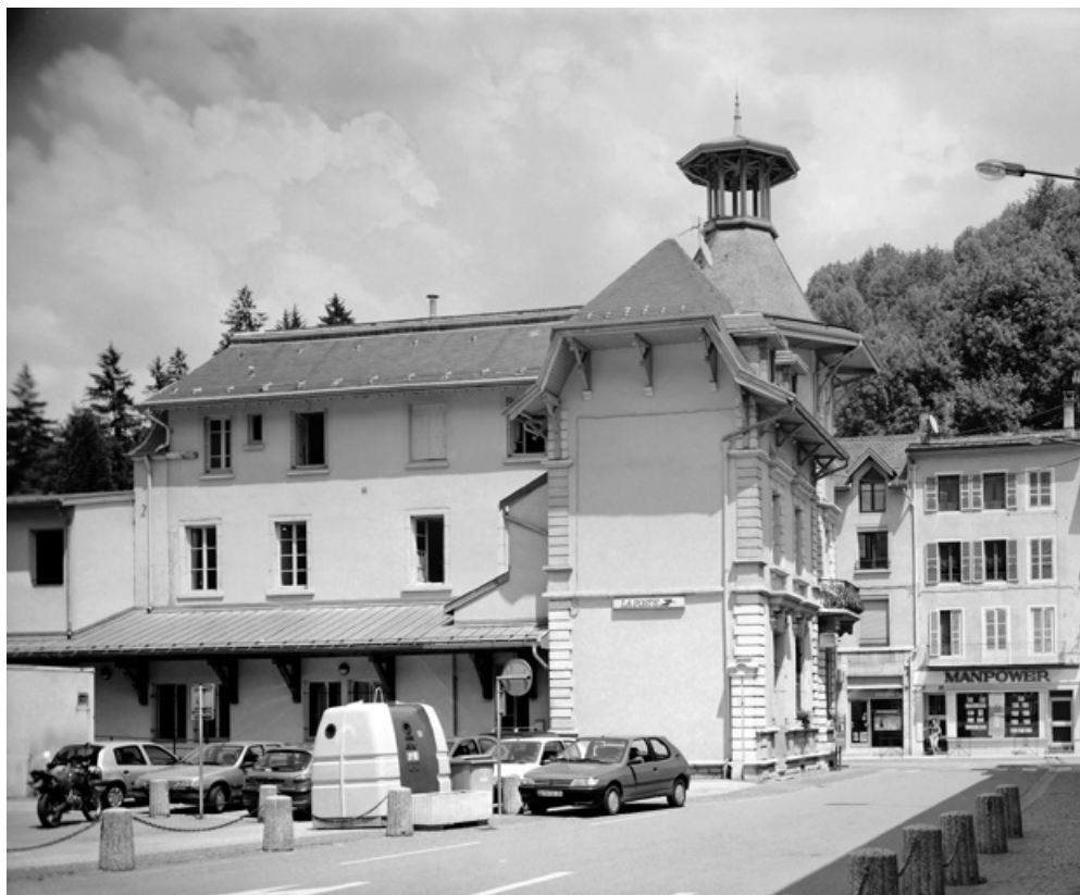
Façade postérieure, depuis la rue Lamartine (sud-ouest).
