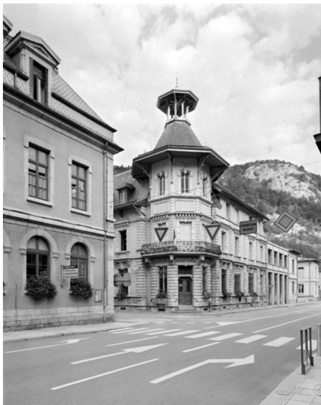
Façade antérieure, depuis la rue de la République (sud-est). 39, Morez, 108 rue de la République
