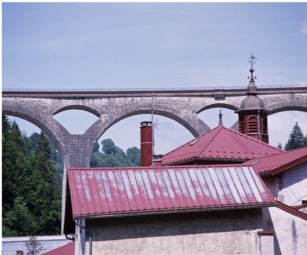
Toitures et clocher avec le grand viaduc en arrière-plan.
