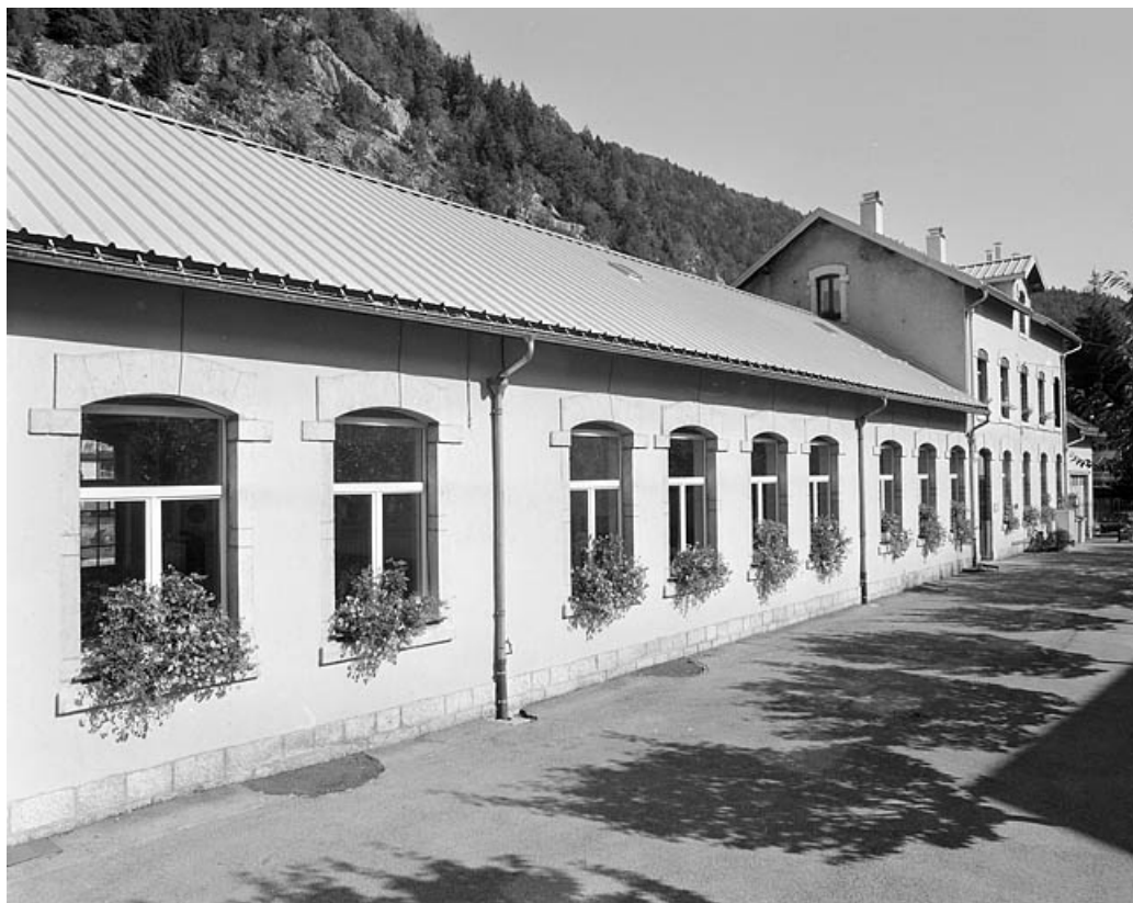
Corps de bâtiment en rez-de-chaussée, de trois quarts gauche.
