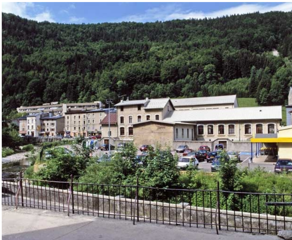
Façade postérieure, depuis la rive droite de la Bienne.
