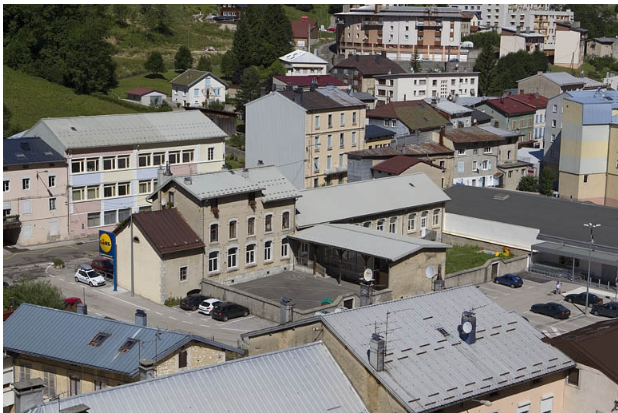
Vue d'ensemble plongeante, depuis l'est.
