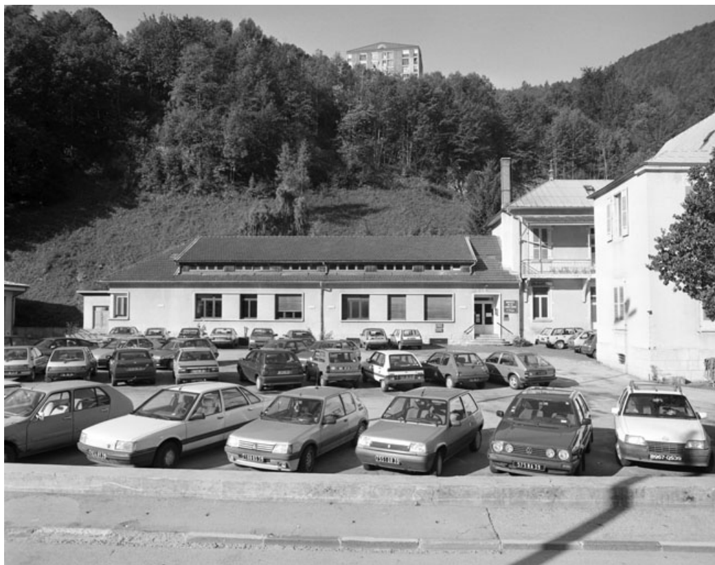
Aile latérale gauche. Le musée de la lunetterie était abrité dans le comble.
