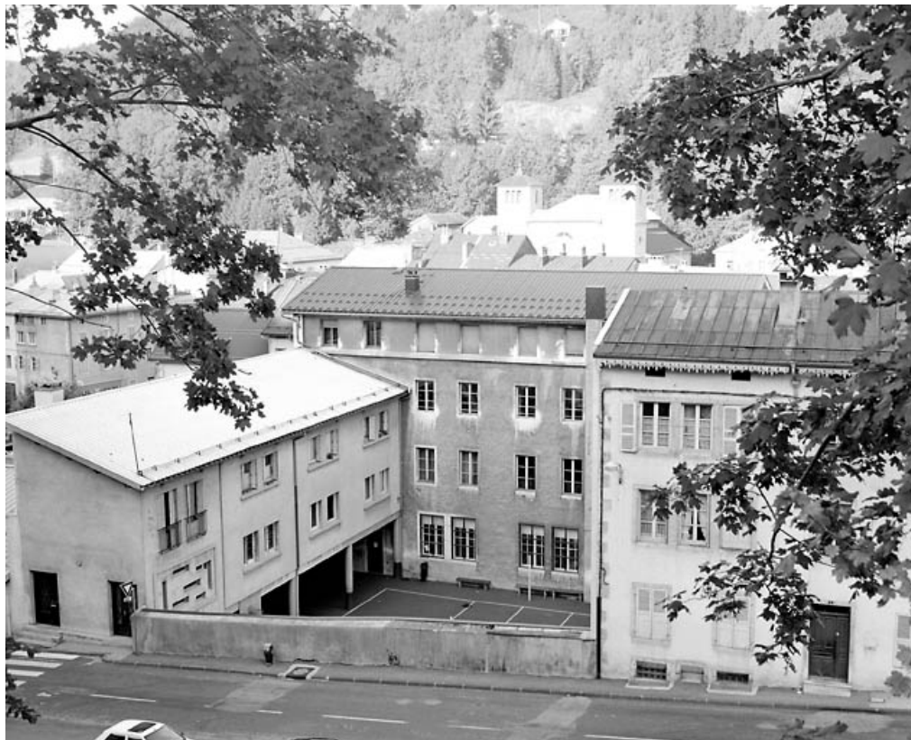
Façade postérieure : vue d'ensemble éloignée, de trois quarts droite. 39, Morez, 28 quai Jobez
