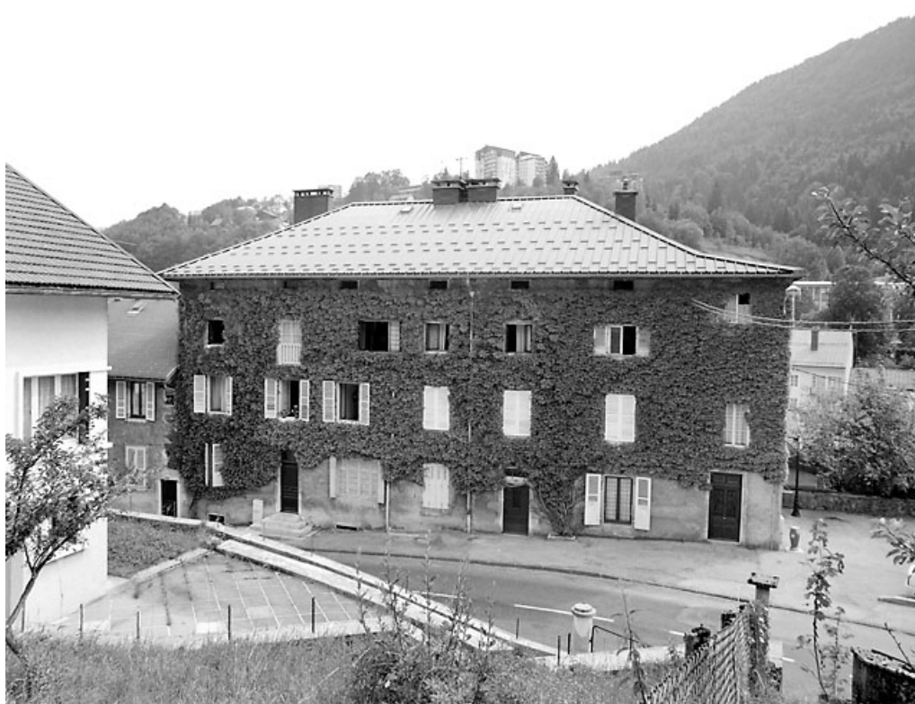
Bâtiment 11-15 rue Pasteur : façade antérieure.
