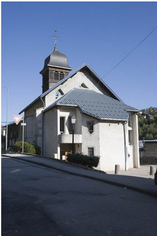
Vue d'ensemble, depuis le sud.
