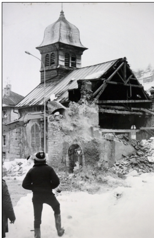
[Démolition du chœur de l'église], 1981 39, Morez, 19 rue Pasteur
