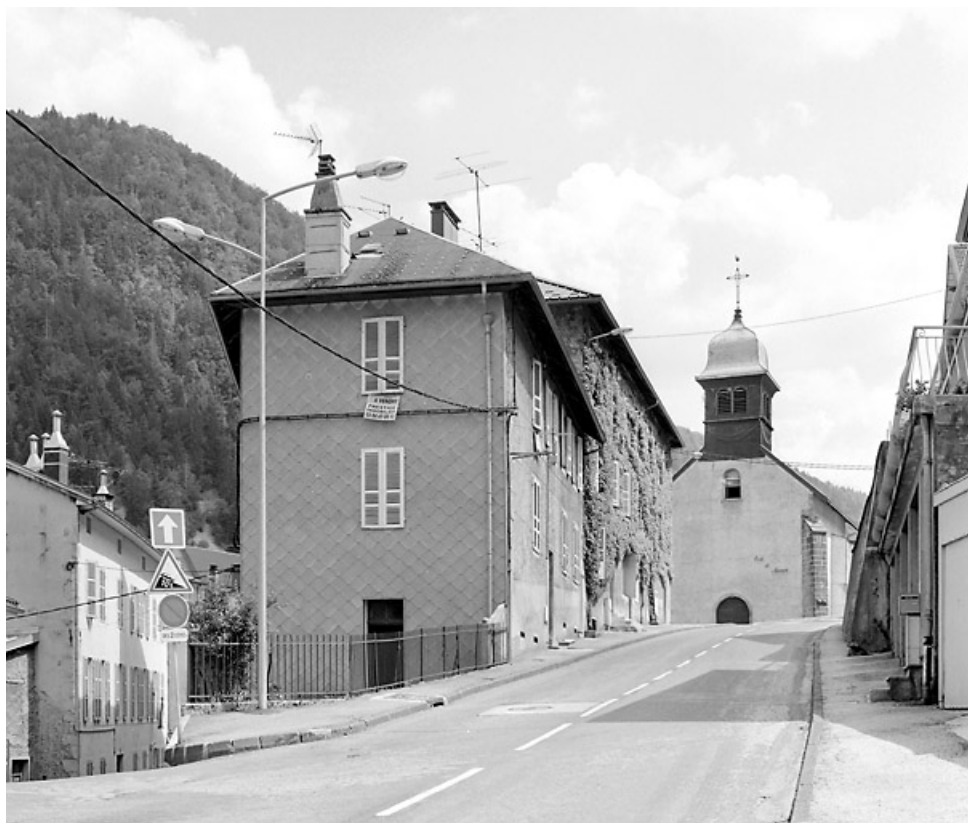
Vue d'ensemble éloignée, depuis la rue Pasteur (nord-ouest). 39, Morez, 19 rue Pasteur
