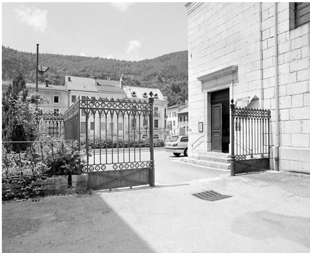
Grille à l'entrée de la cour.
