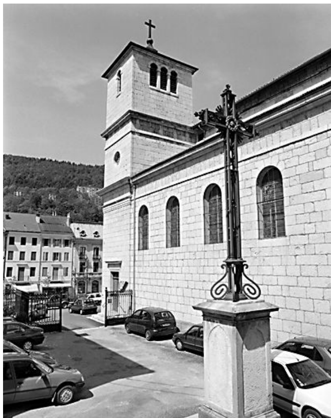
Vue d'ensemble de la croix, en avant de l'élévation latérale droite de l'église. 39, Morez place Notre-Dame
