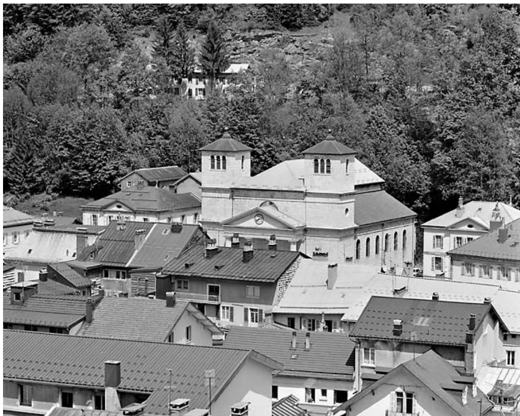
Vue d'ensemble rapprochée du quartier de l'église, depuis le sud-ouest. 39, Morez place Notre-Dame
