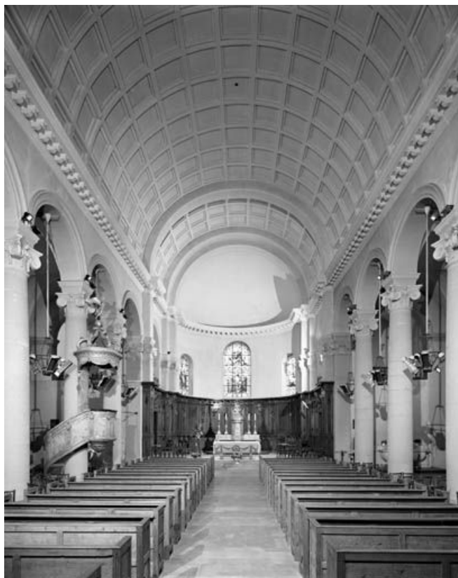
Le chœur et la nef, depuis l'entrée.
