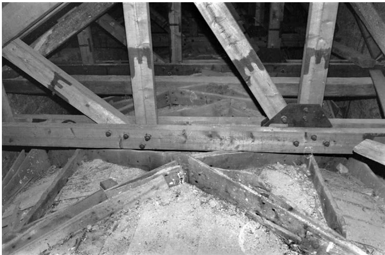
Extrados de la fausse voûte d'arêtes de l'un des bas-côtés.
