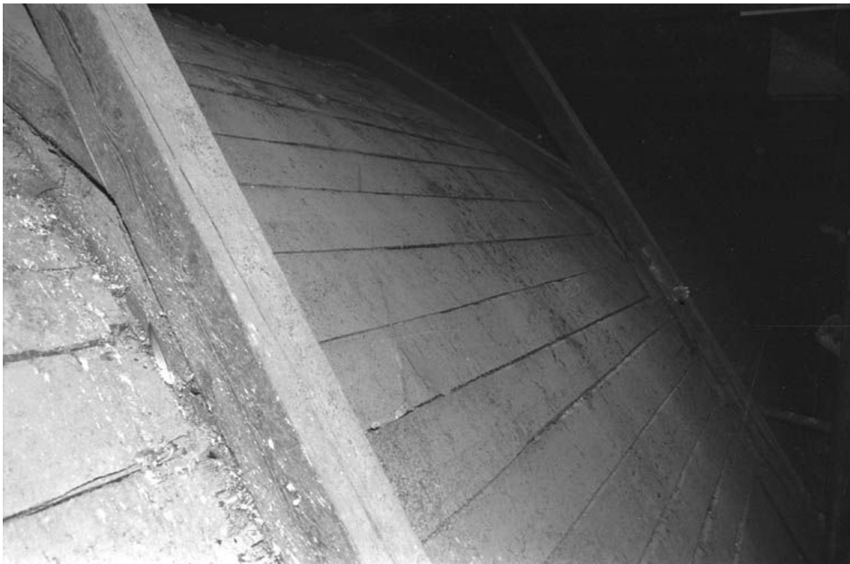
Extrados de la fausse voûte en berceau de la nef.
