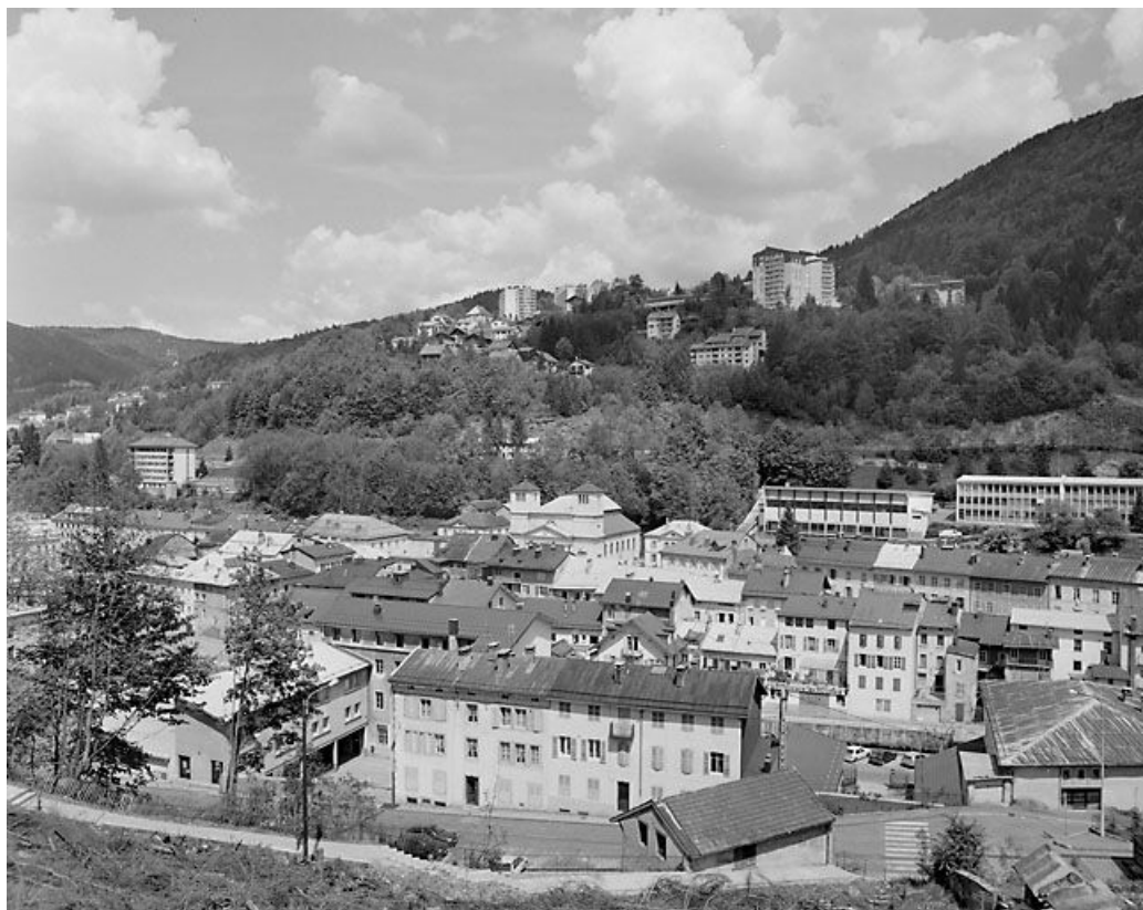
Vue d'ensemble du quartier de l'église, depuis le sud-ouest.
