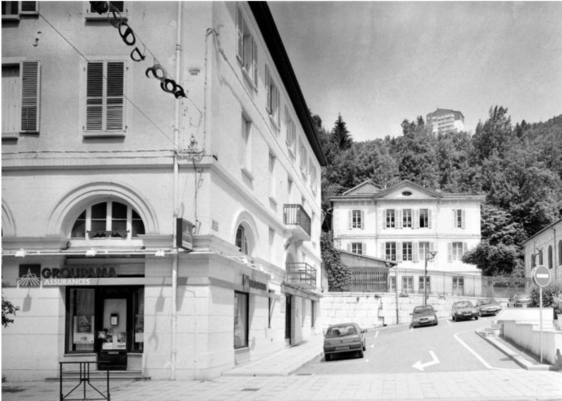
Vue d'ensemble, côté nord : immeuble et école Notre-Dame. 39, Morez place Notre-Dame
