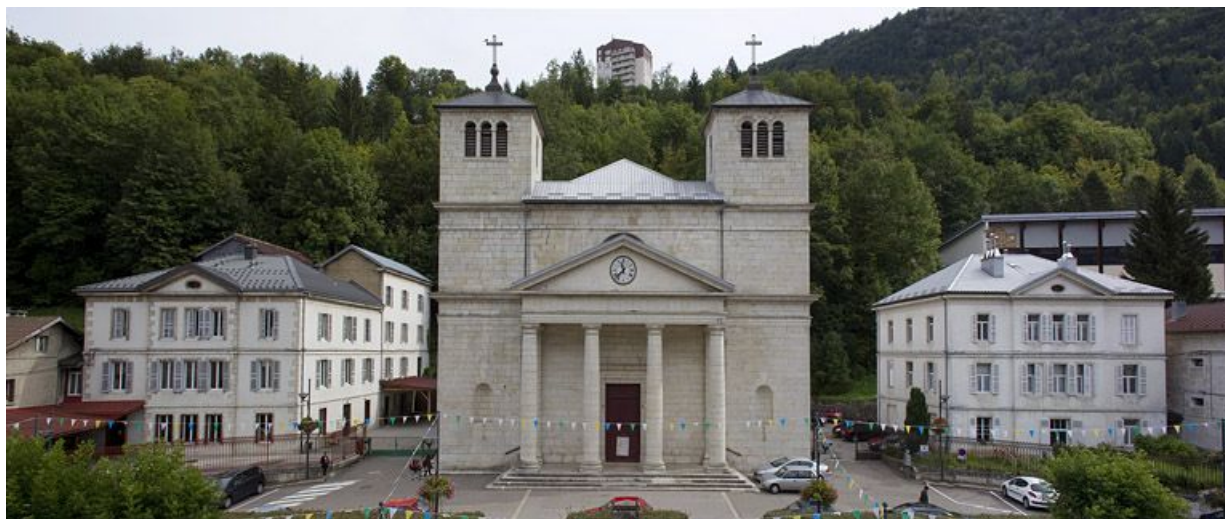
Vue d'ensemble de la place et des bâtiments côté est : école, église et presbytère.
