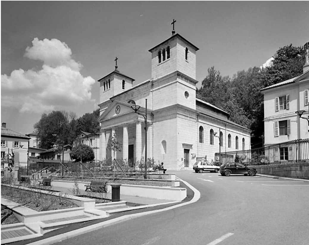
Vue d'ensemble rapprochée, côté est : église.
