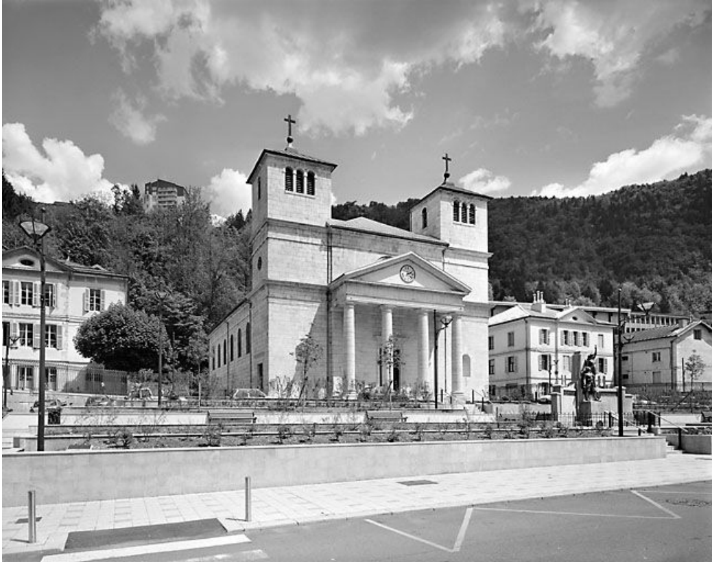
Vue d'ensemble, côté est : école Notre-Dame, église, presbytère et monument aux morts. 39, Morez place Notre-Dame
