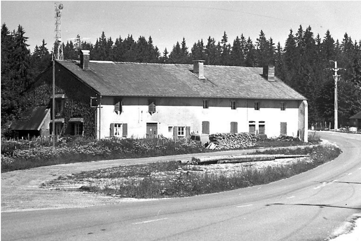
Vue éloignée de la façade antérieure.
