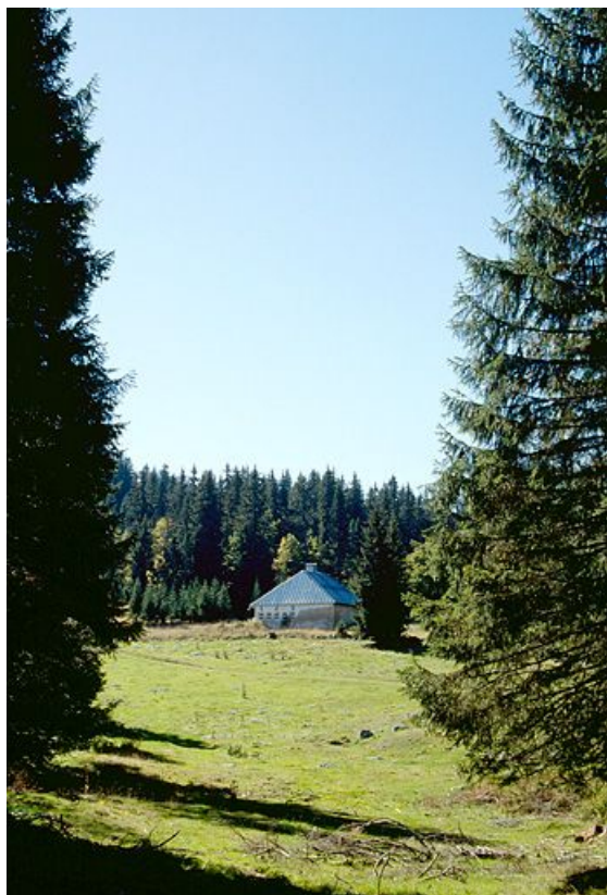
Vue de situation du chalet d'estive du Petit Boulu.
