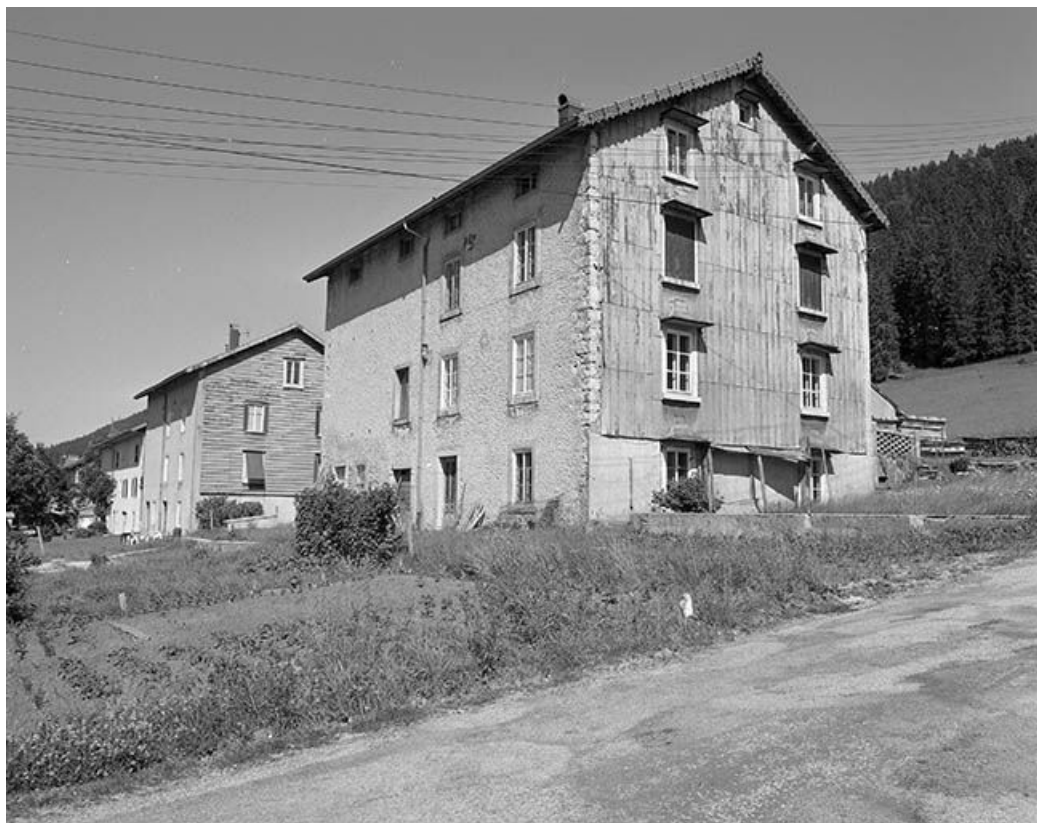
Vue de trois quarts de la façade postérieure et de la face gauche.
