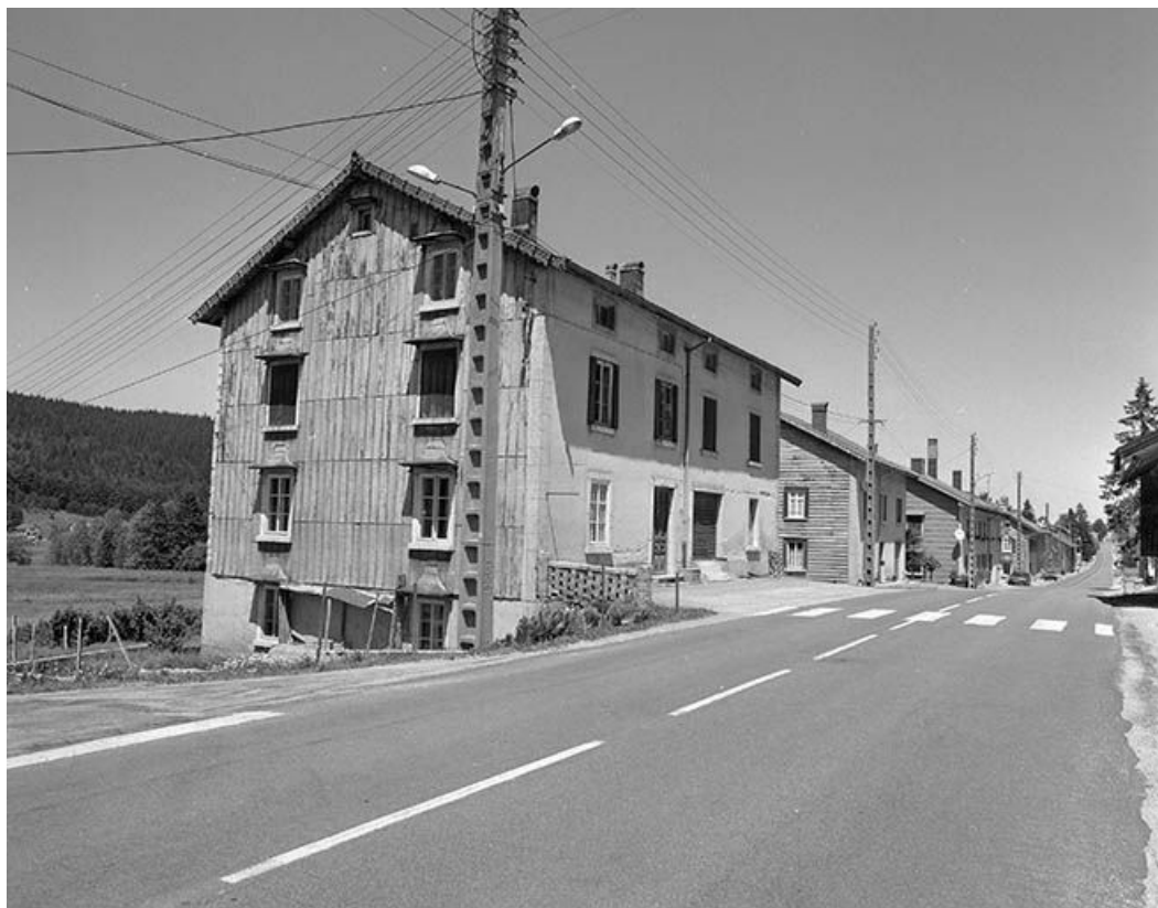
Vue de trois quarts de la façade antérieure et de la face gauche.
