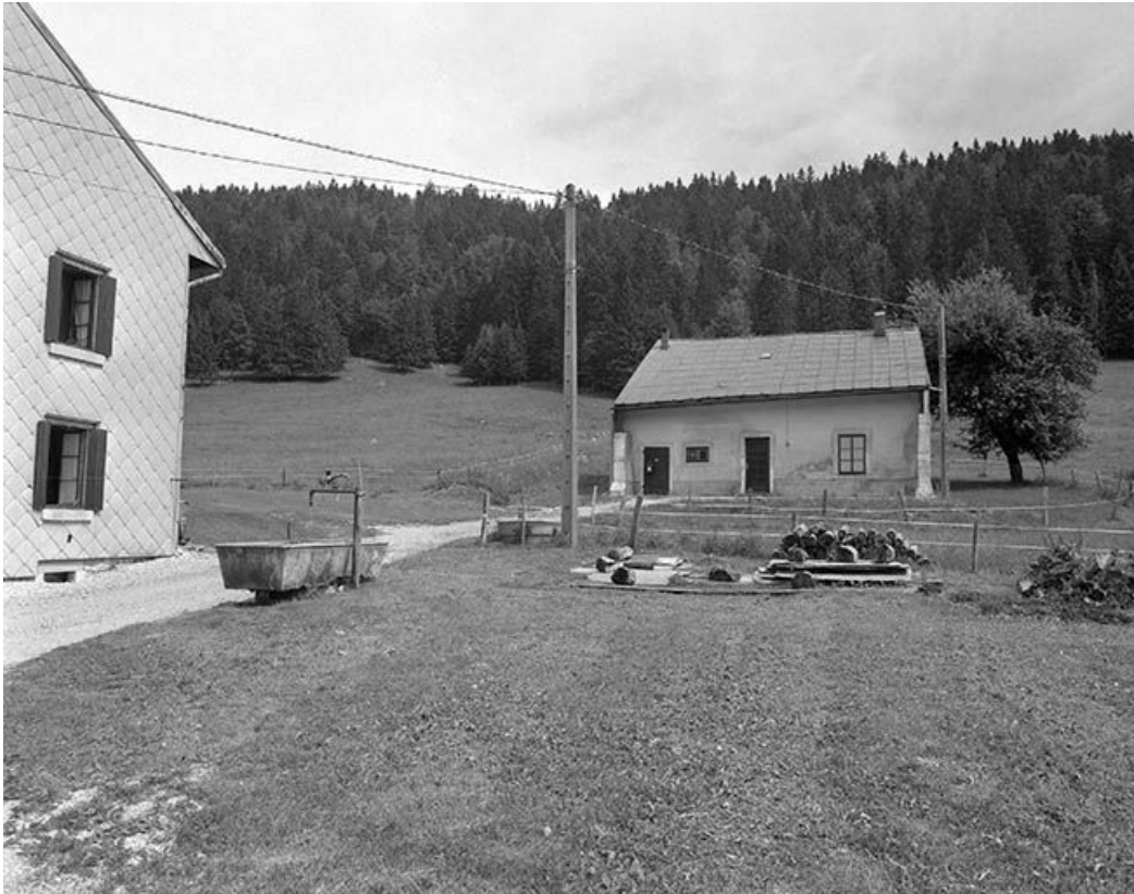
Vue générale depuis la route.
