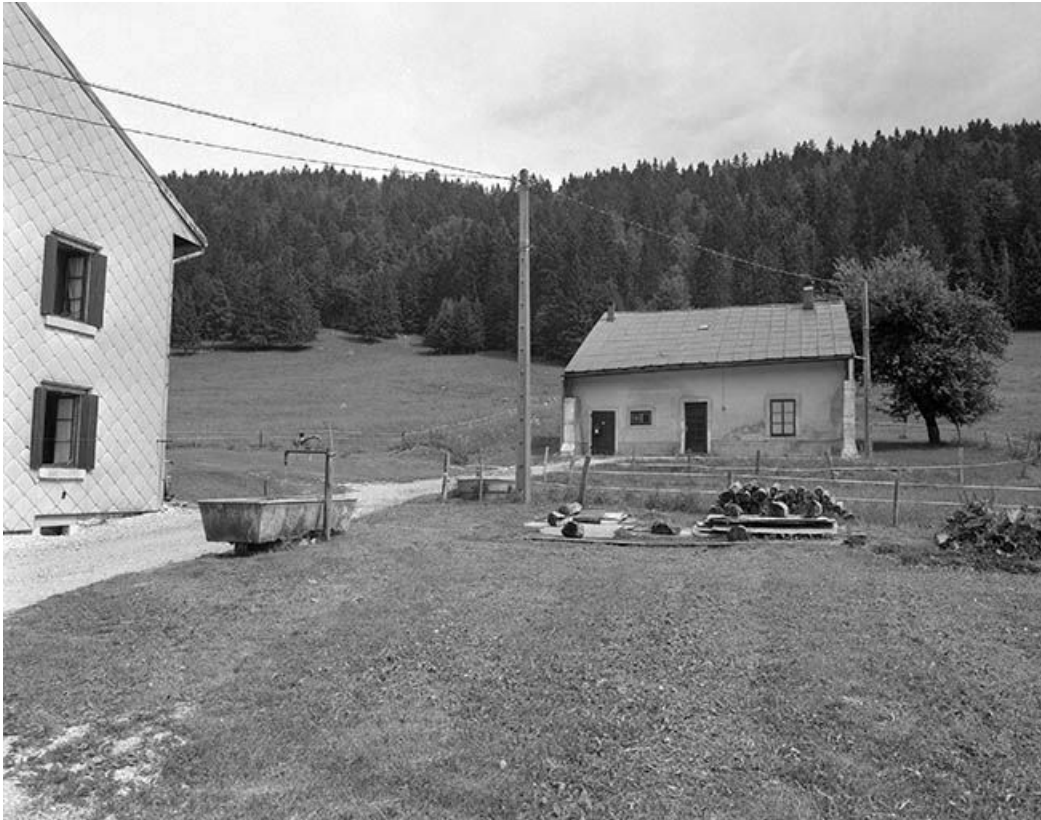
Vue générale depuis la route.
