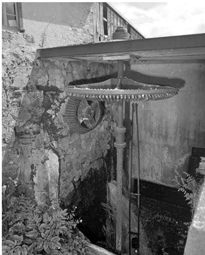
Système de roues hydrauliques, vue rapprochée.
