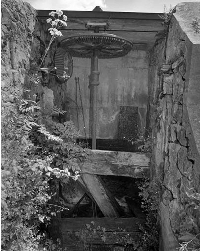
Système de roues hydrauliques, vue générale.
