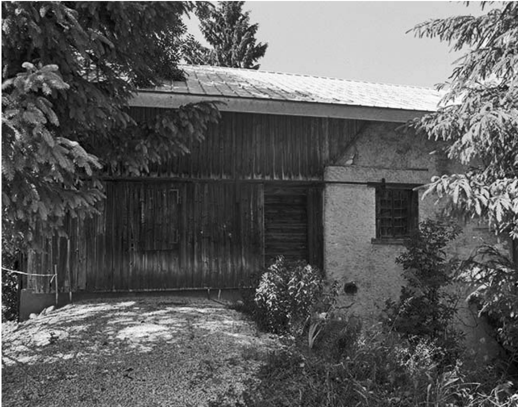
Façade antérieure du bâtiment abritant la scierie.
