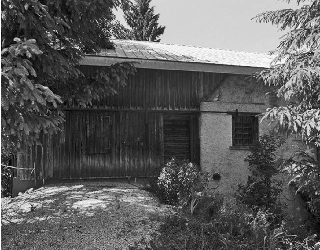
Façade antérieure du bâtiment abritant la scierie.
