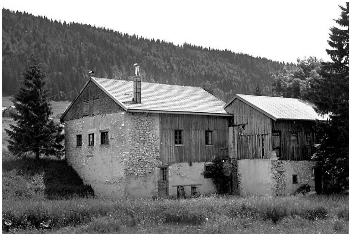
Façade le long de l'Orbe et face droite.
