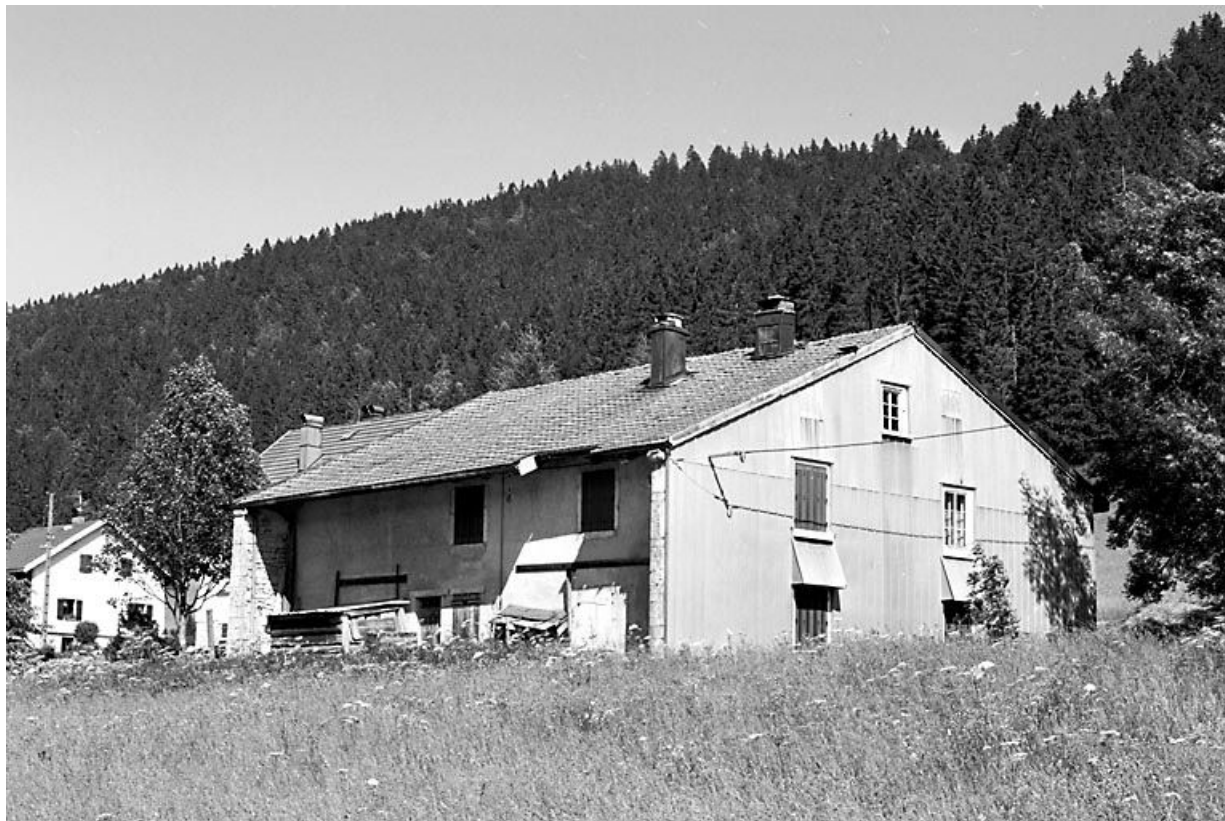
Façade antérieure et face droite.
