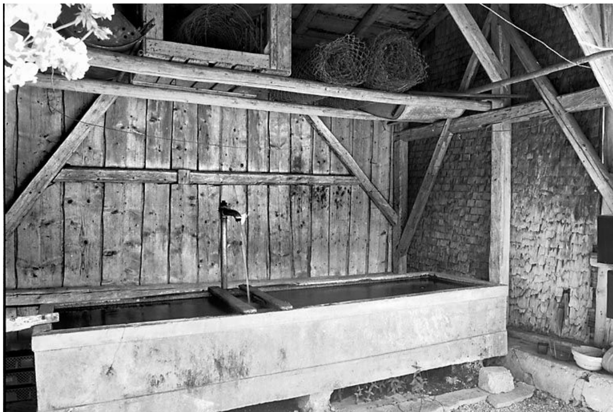
Vue du réservoir et de la charpente.
