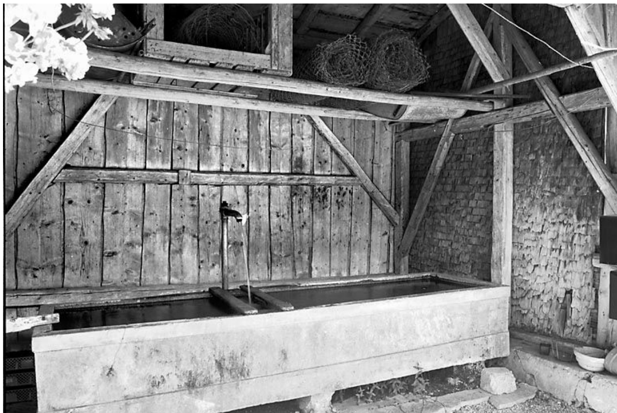
Vue du réservoir et de la charpente.
