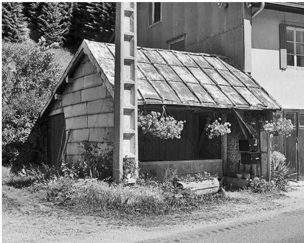
Vue depuis le sud-ouest.
