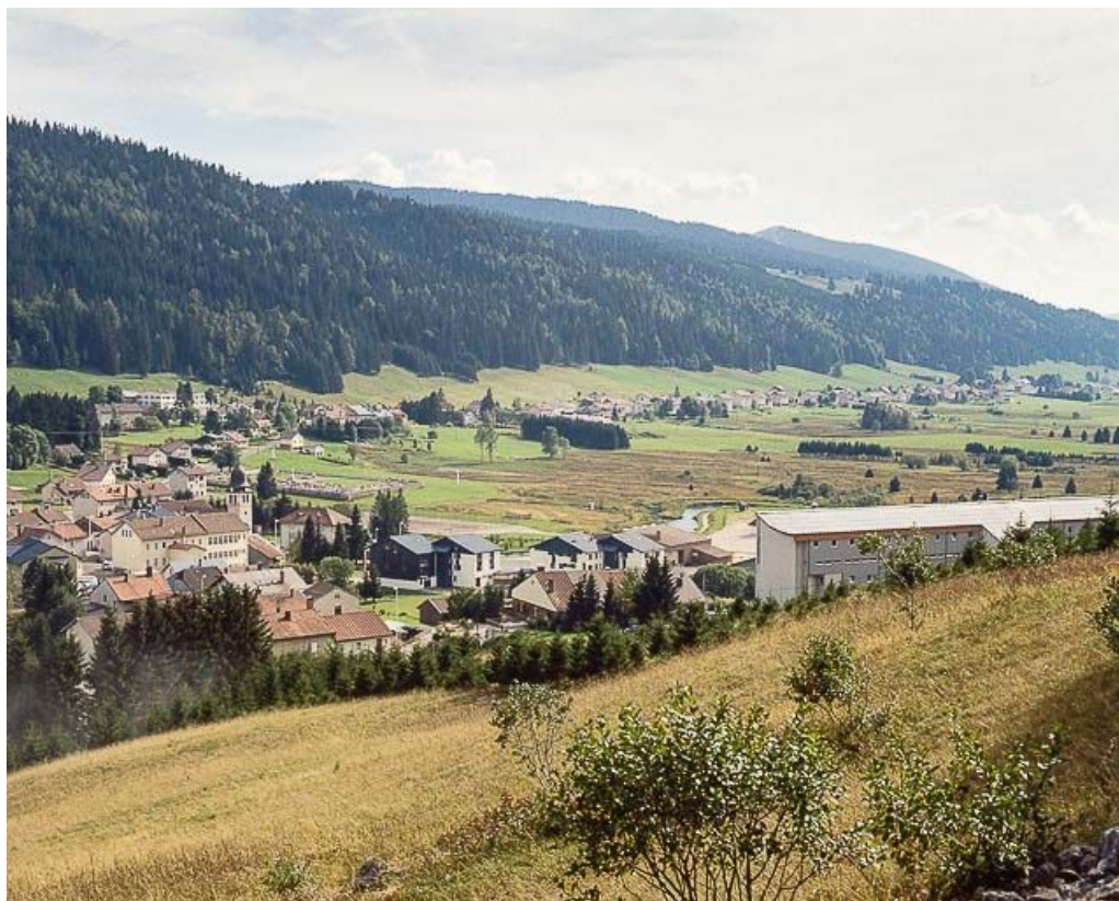
Vue générale depuis le nord-est. 39, Bois-d'Amont
