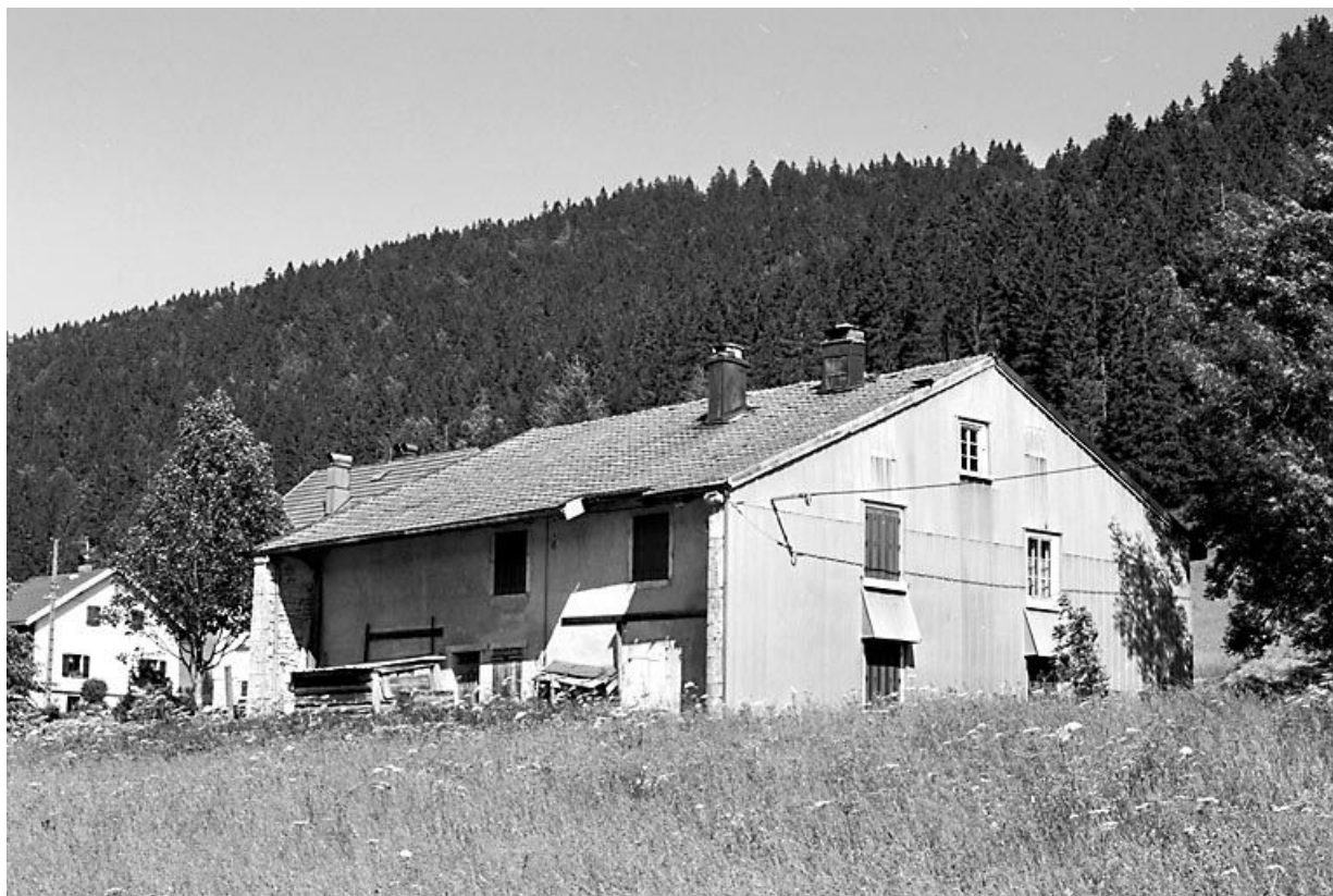
Façade antérieure et face droite.
