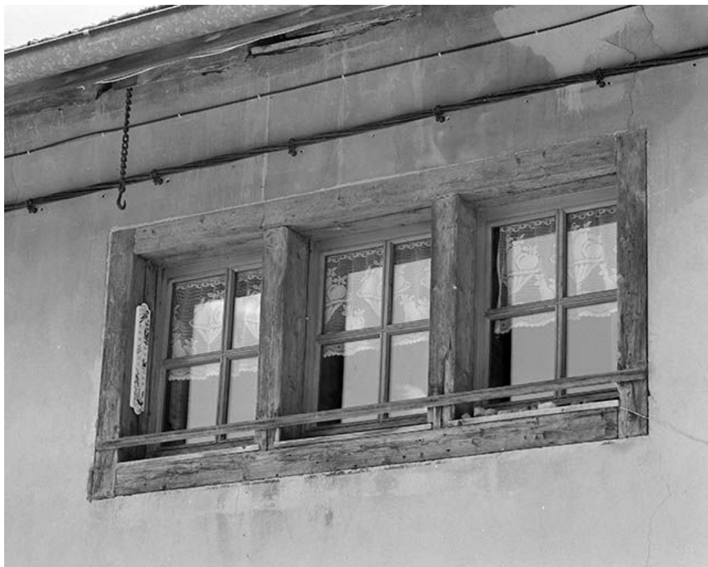
Fenêtres d'atelier appelées aussi "fenêtres de forge" ou baies lunetières. 39, Bellefontaine
