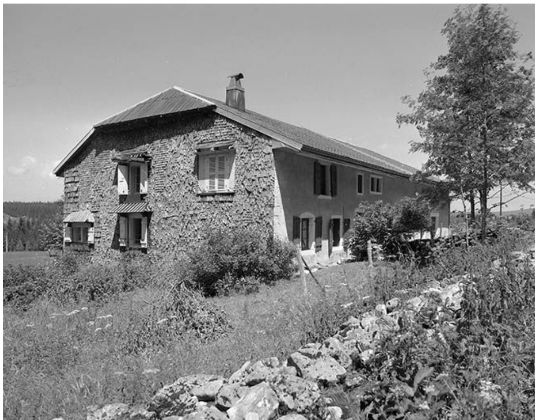
Façade postérieure et face droite vues de trois quarts.
