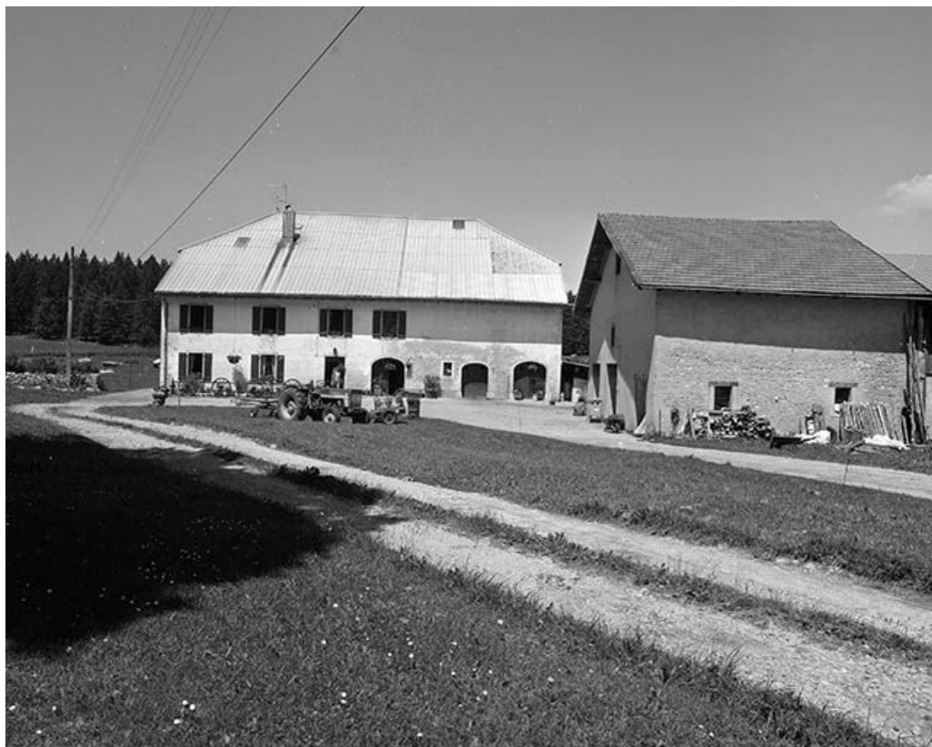
Vue éloignée de la façade antérieure.
