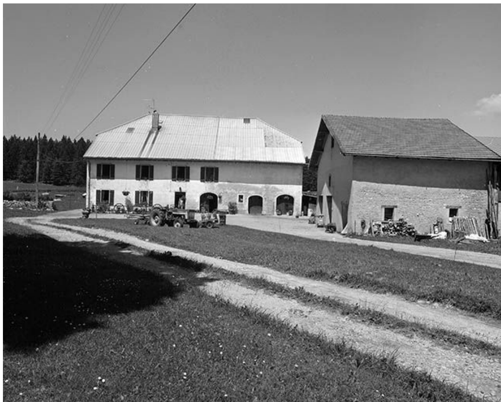
Vue éloignée de la façade antérieure.
