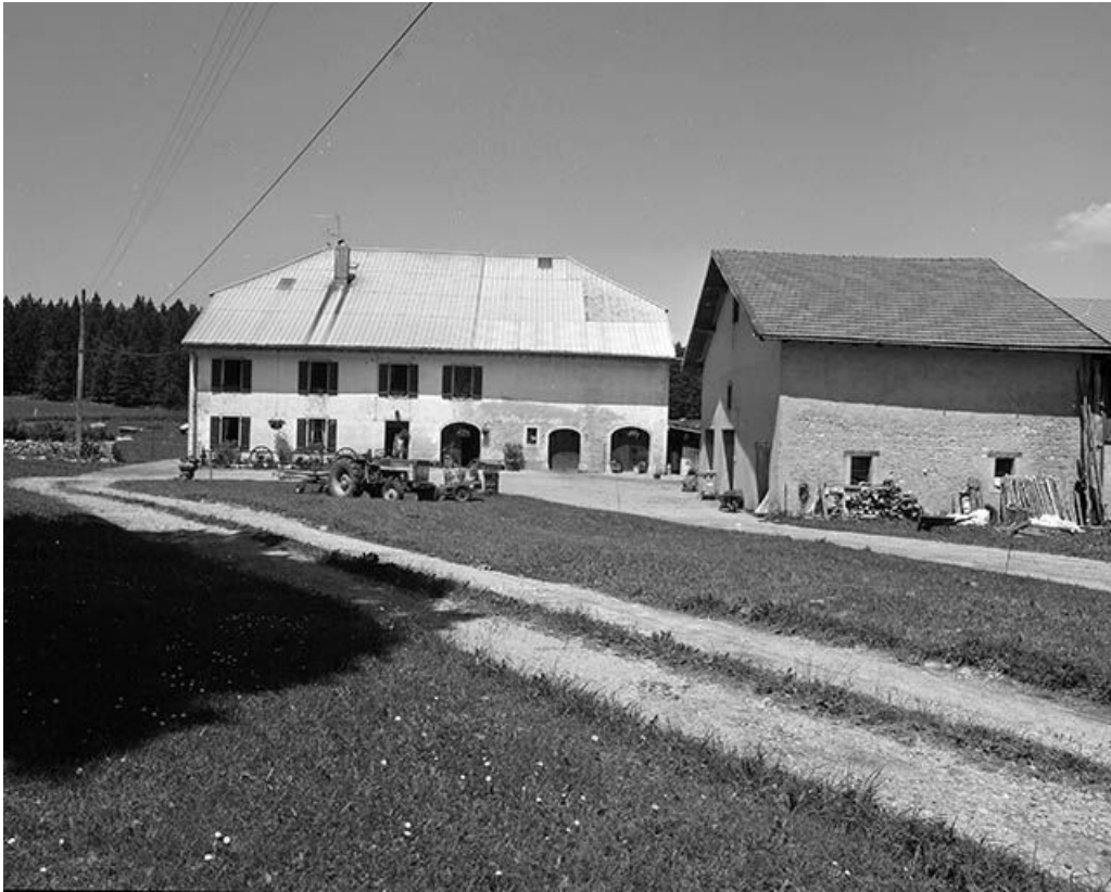
Vue éloignée de la façade antérieure.
