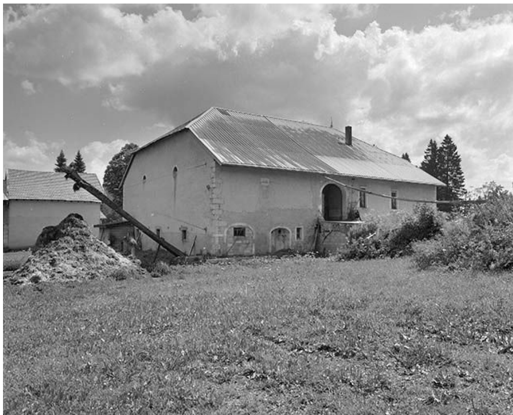
Façade postérieure et face droite.
