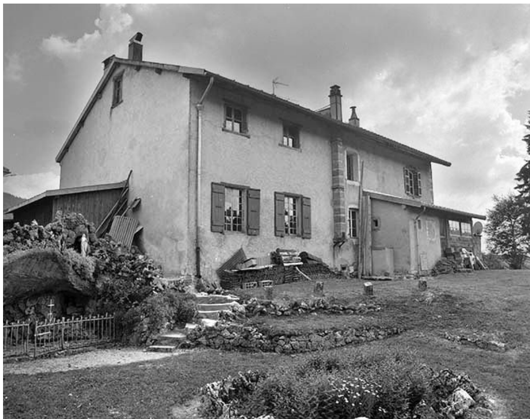
Façade postérieure et face droite.
