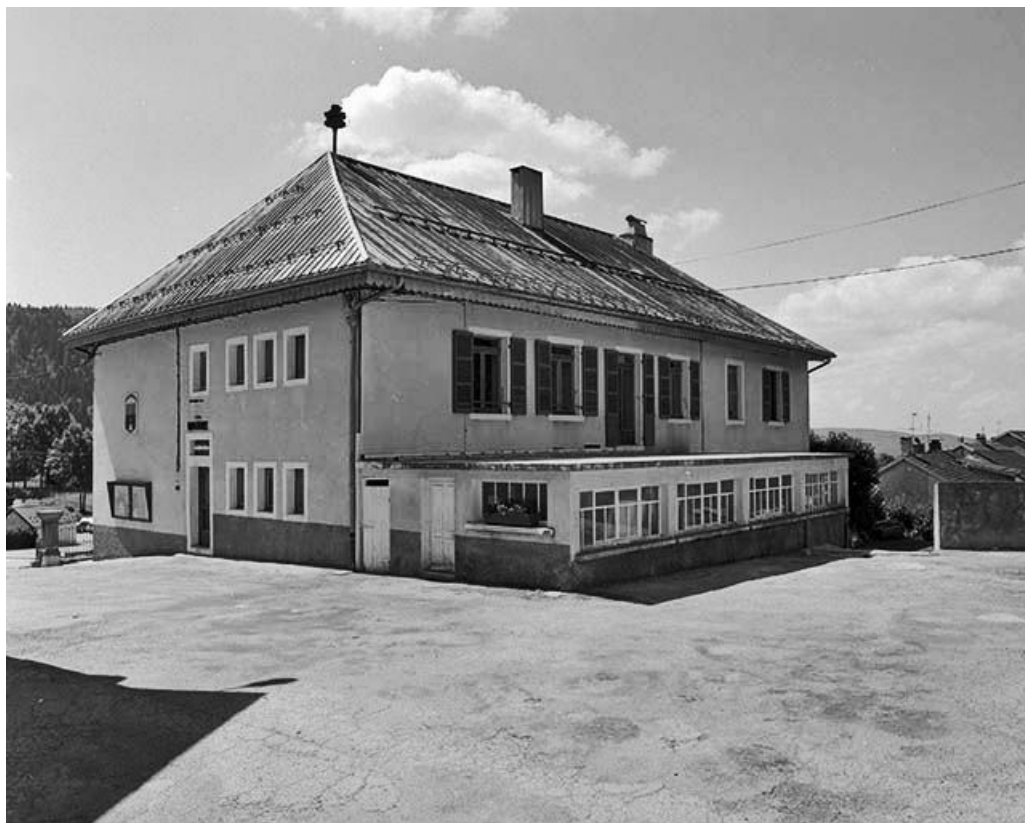
Façade postérieure et face droite vues de trois quarts.
