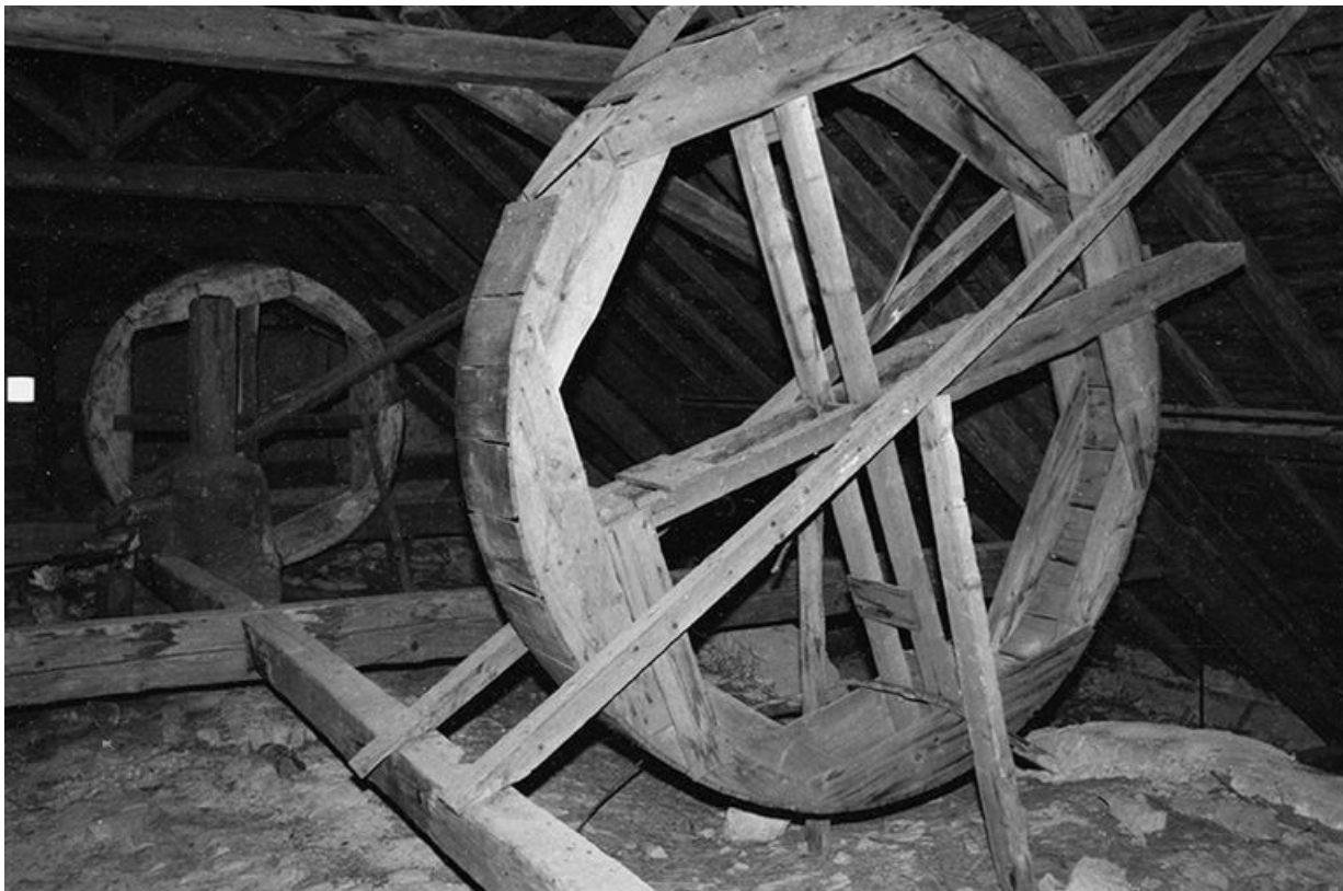
Combles : treuils autrefois utilisés pour descendre et monter les lustres ?
