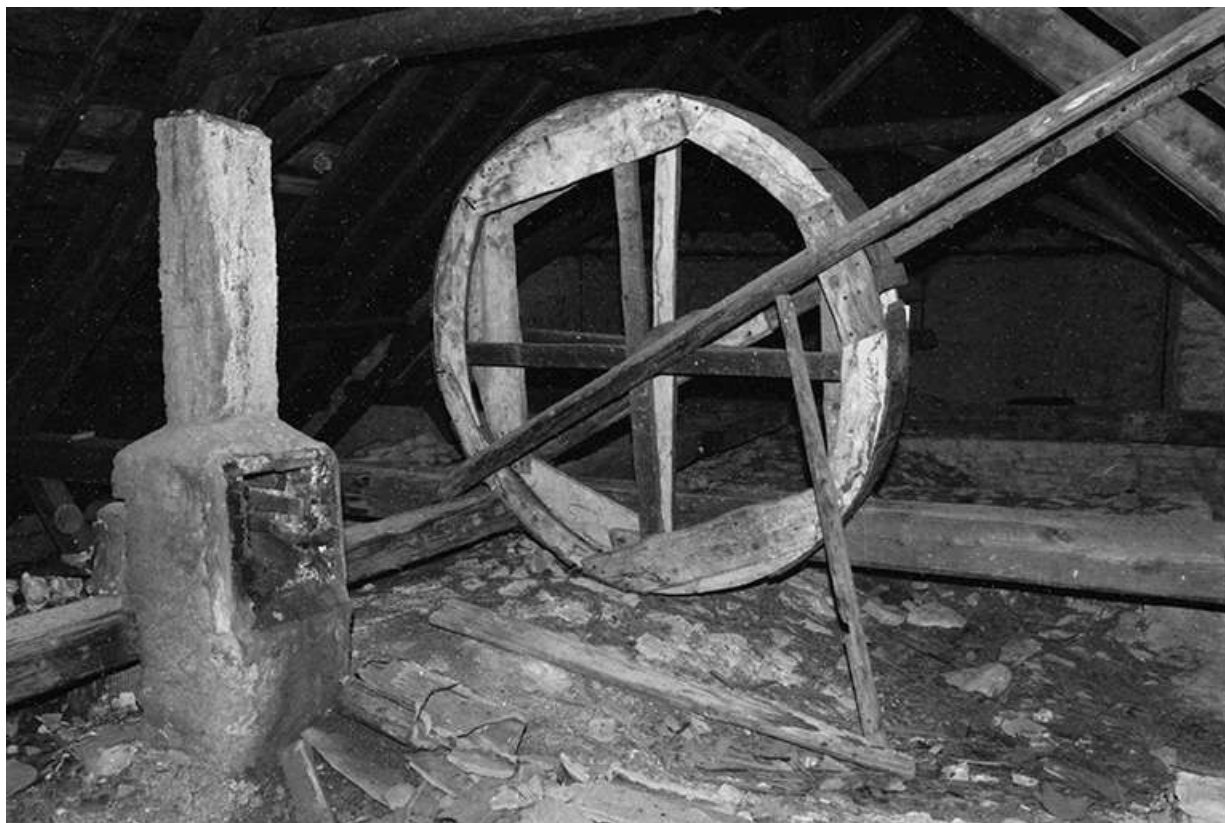
Combles : l'un des treuils.
