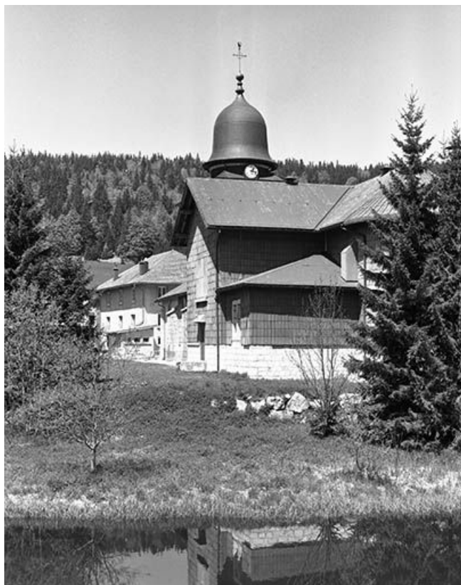
Vue de l'église depuis le sud.
