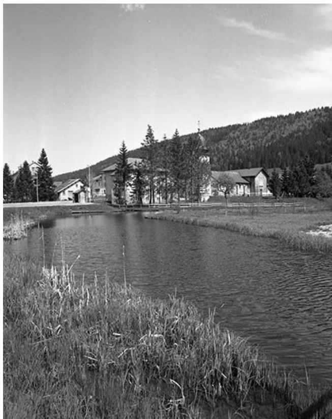
Vue éloignée de l'église (vue verticale).
