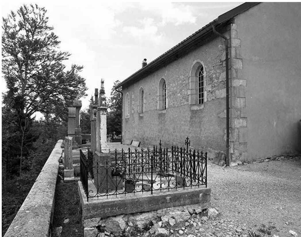
Façade gauche vue de trois quarts.
