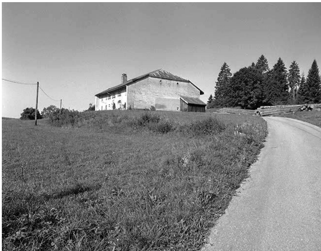
Façade antérieure, vue éloignée de trois quarts droit.
