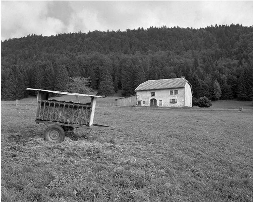
Façade antérieure, vue éloignée.
