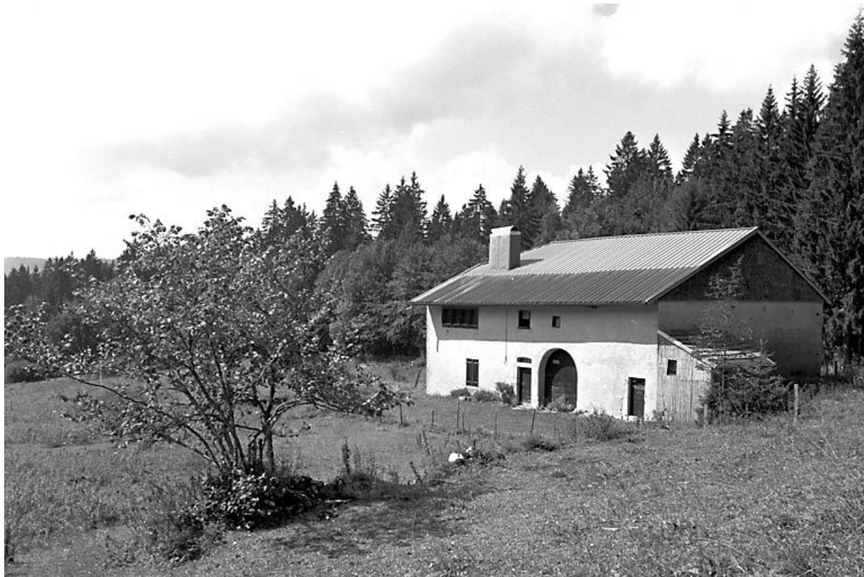
Façade sud-est, vue éloignée.
