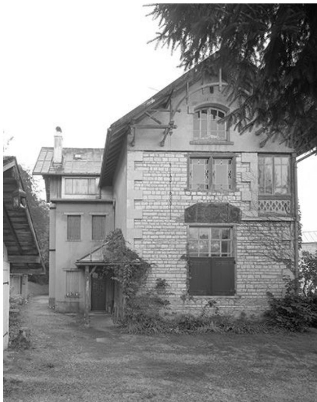
Vue rapprochée de la façade nord-ouest.
