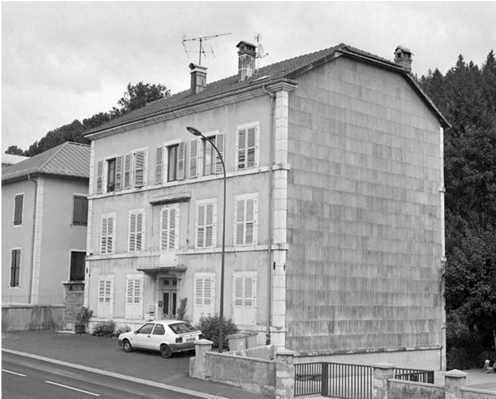
Façade antérieure et face droite vues de trois quarts.
