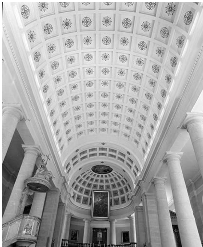
La fausse voûte en plein cintre du vaisseau central.
