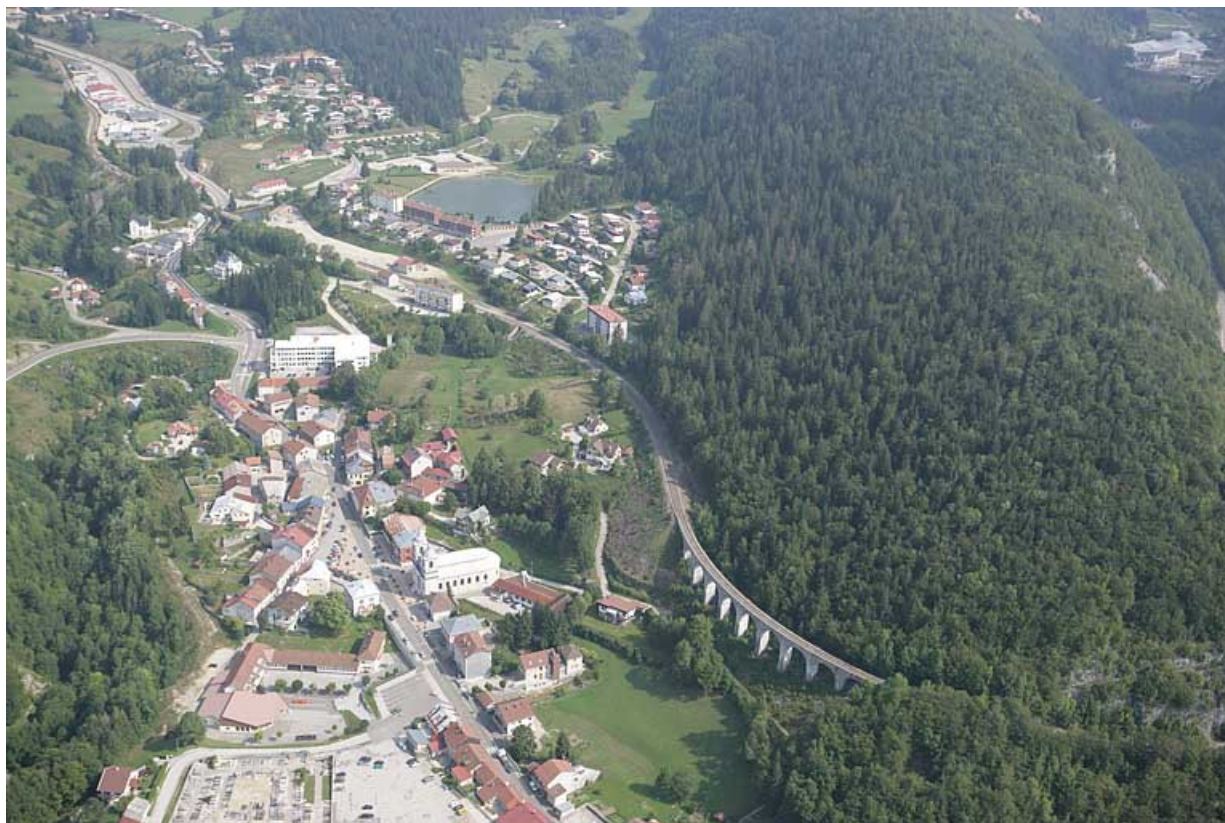
Vue aérienne, depuis le sud-ouest. 39, Morbier
