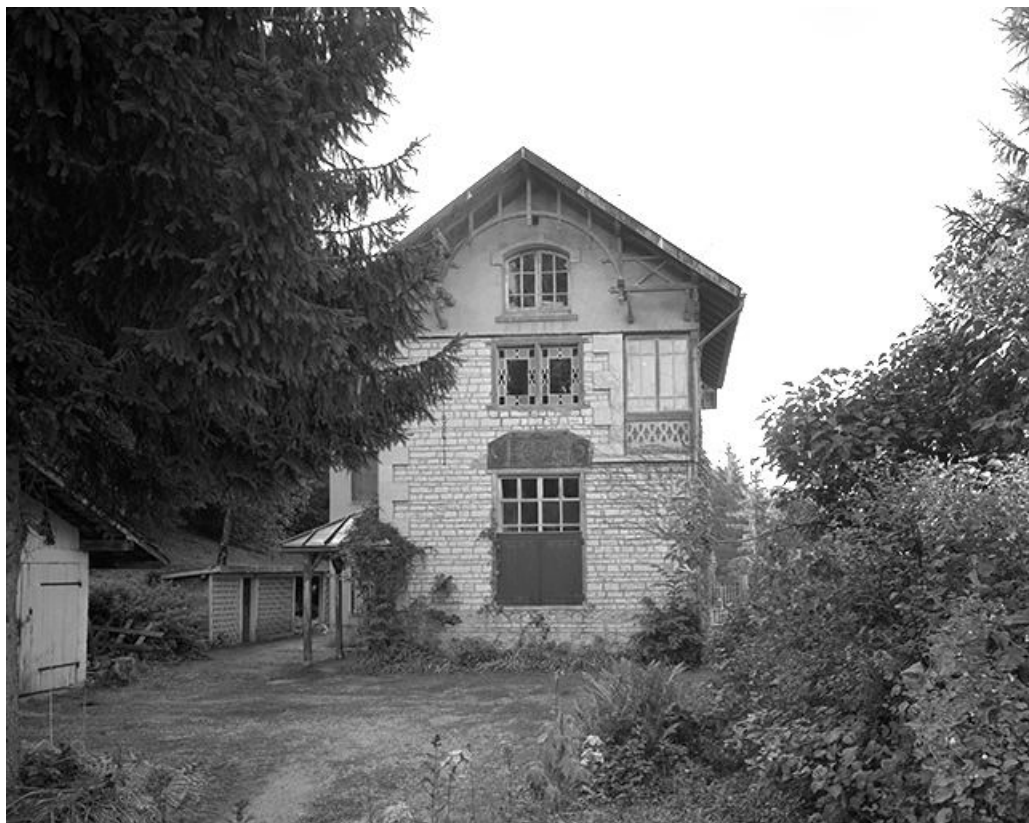
Vue générale depuis le nord-ouest.
