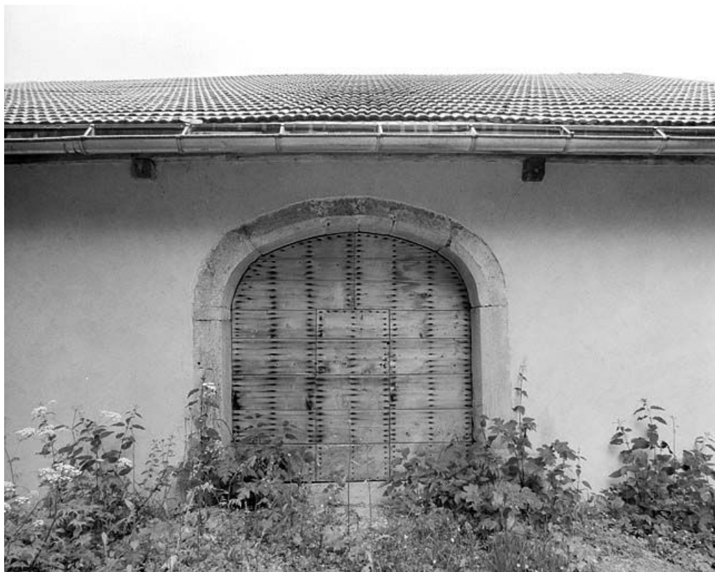
Porte de grange sur la façade postérieure.
