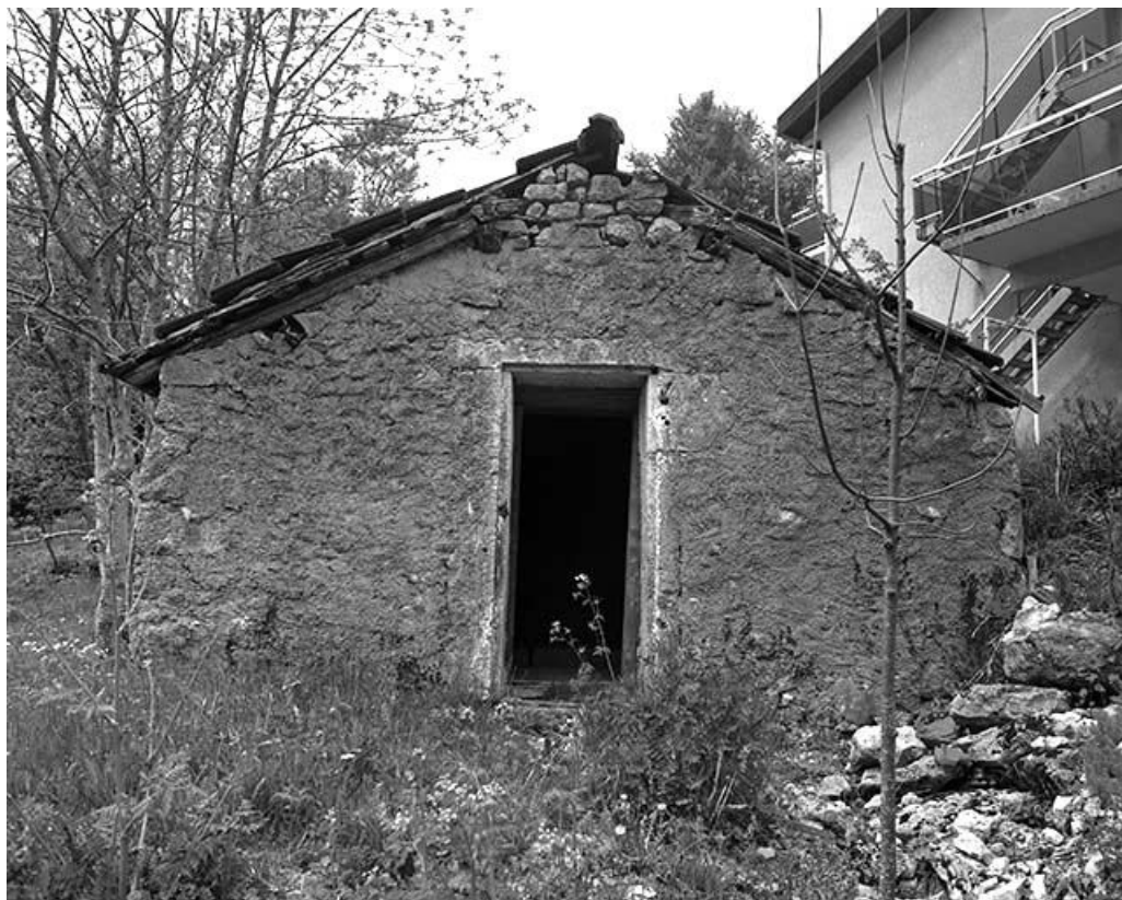
Façade antérieure de la resserre, " grenier fort ".
