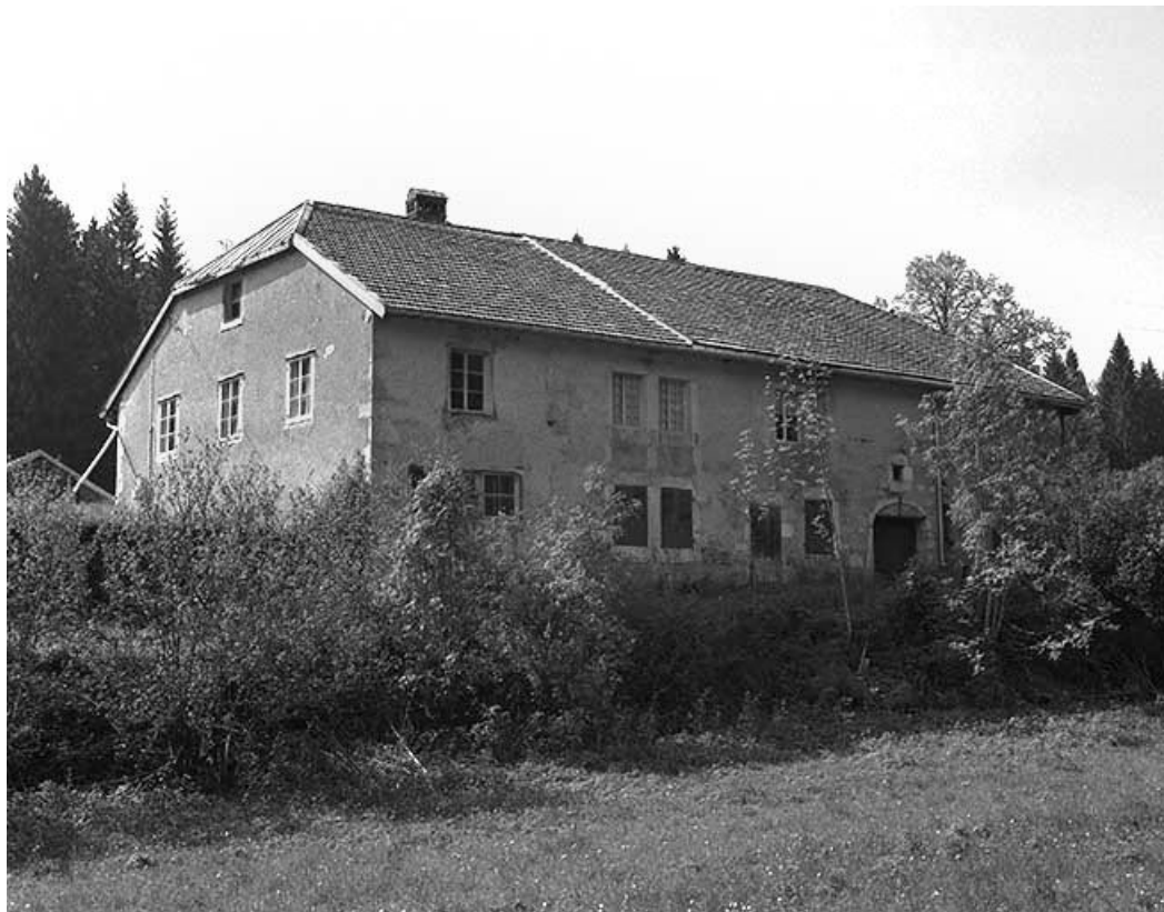
Façade postérieure vue de trois quarts gauche.
