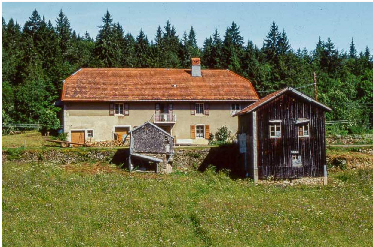
Façade antérieure, " grenier fort " et remise au premier plan.
