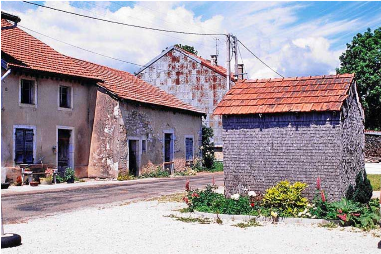
Vue de trois quarts de la façade antérieure et, au premier plan, la resserre. 39, Longchaumois
