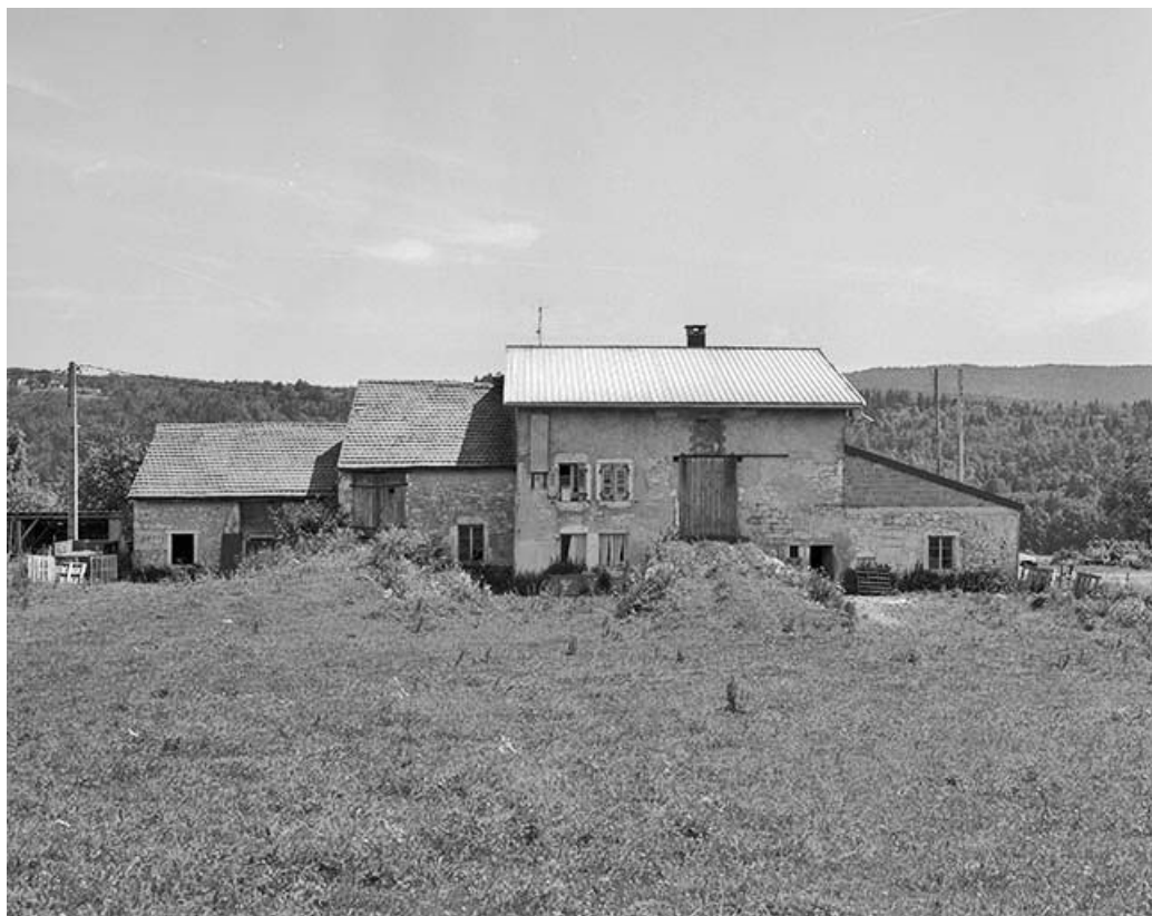
Vue éloignée de la façade postérieure.
