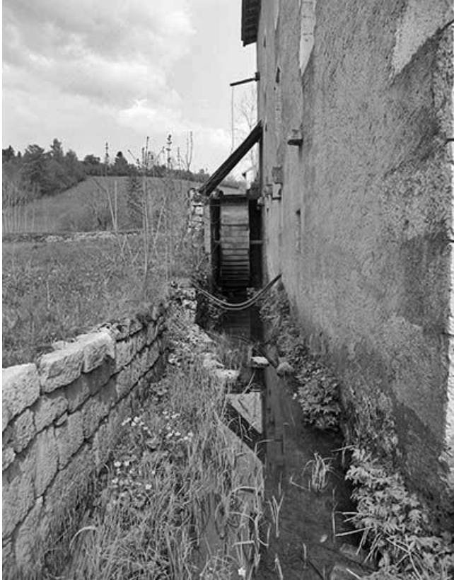
Vue sur la roue à aubes et le canal de fuite.
