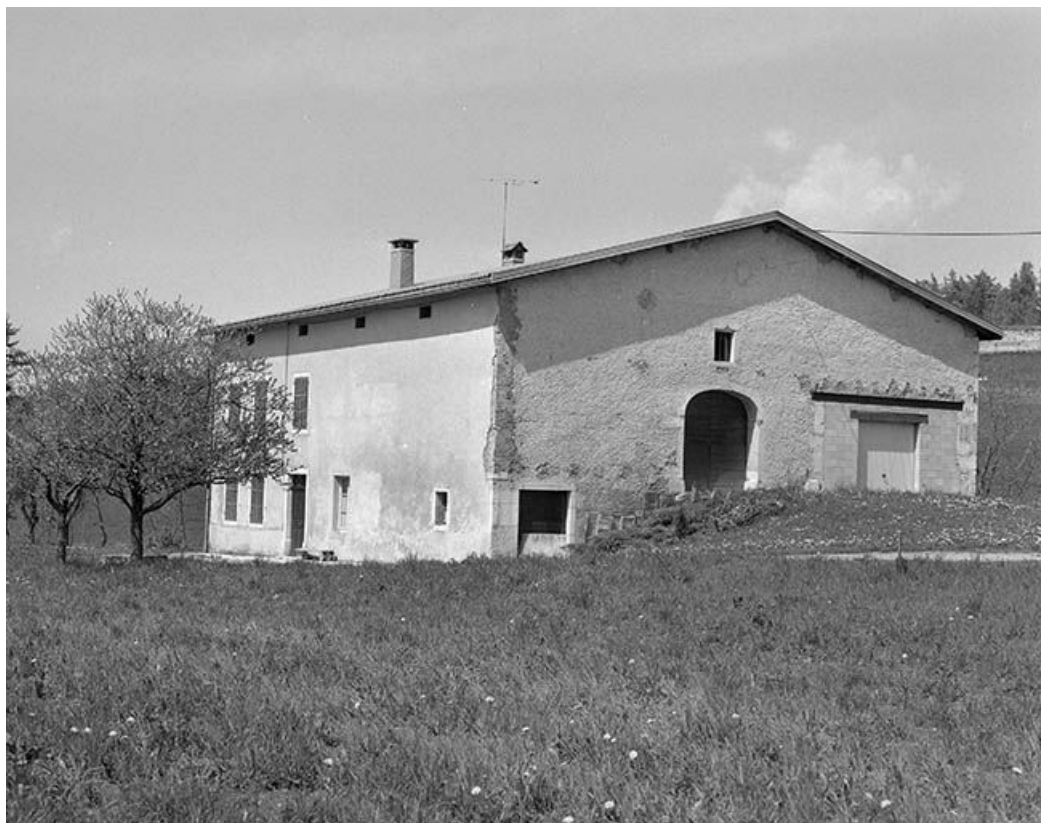
Vue de trois quarts de la façade postérieure et de la face droite.
