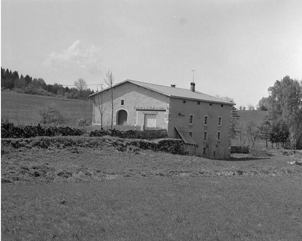
Vue de trois quarts de la façade postérieure et de la face droite.
