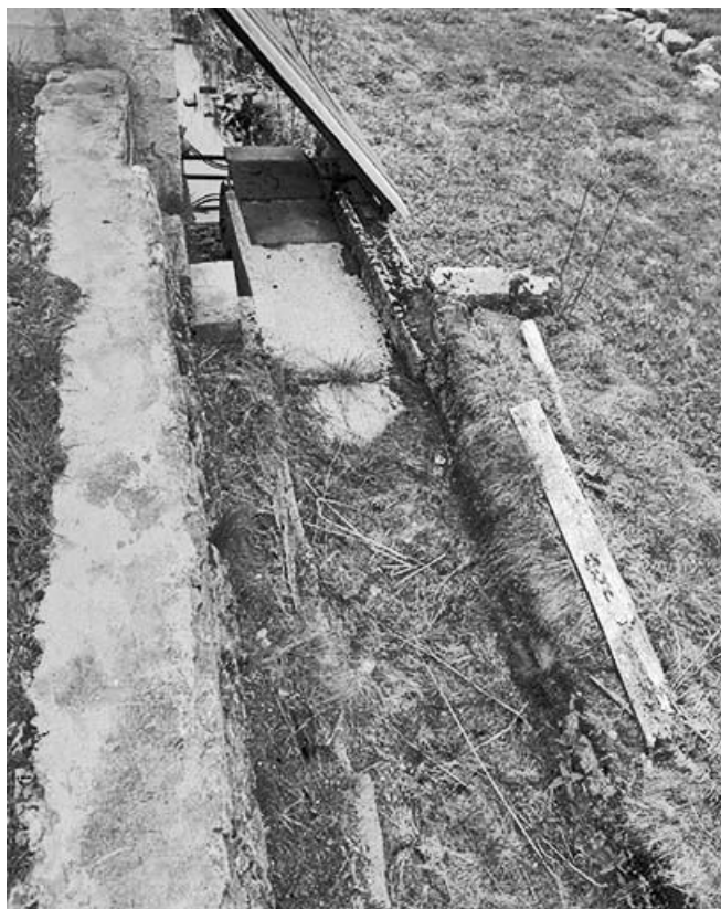
Canal d'amenée d'eau sur la roue ou " arivoir " . 39, Longchaumois, lieudit : les Moulins Piquands
