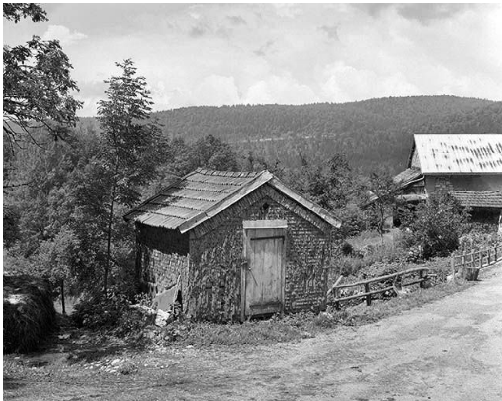
Vue de trois quarts gauche du " grenier fort ".
