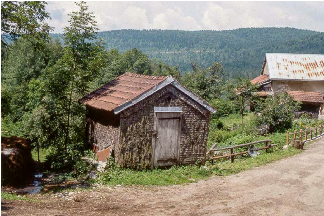
Vue de trois quarts gauche du " grenier fort ".
