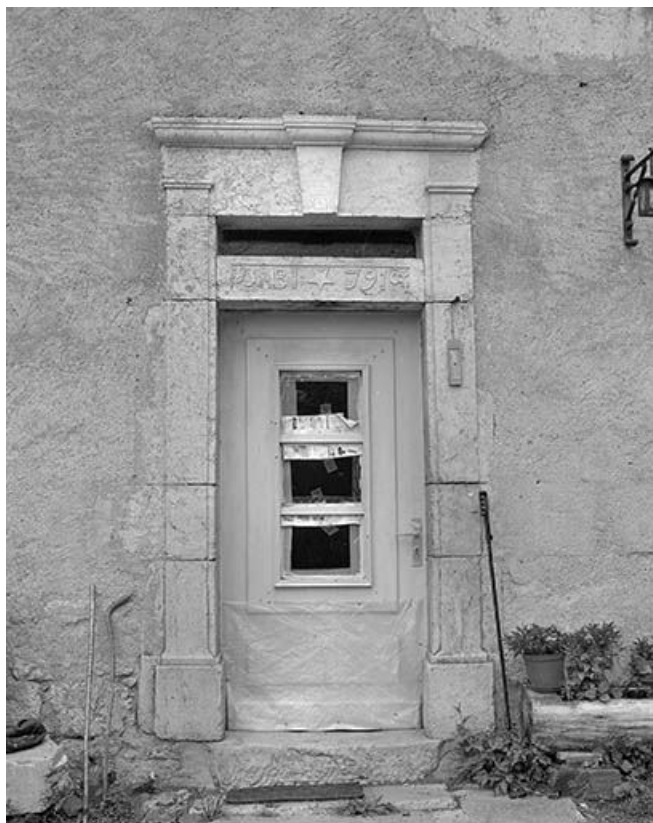
Les piédroits et le linteau de la porte d'accès.
