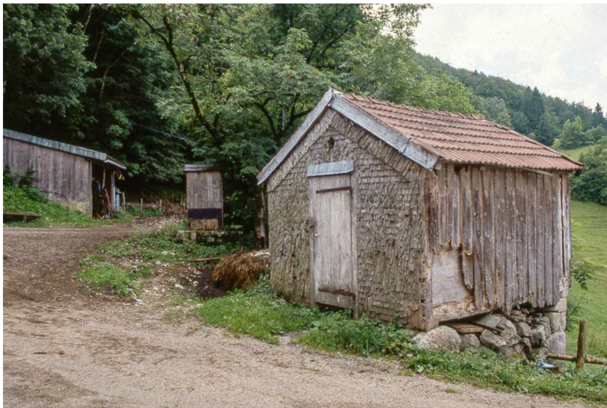
Vue de trois quarts droit du " grenier fort ".
