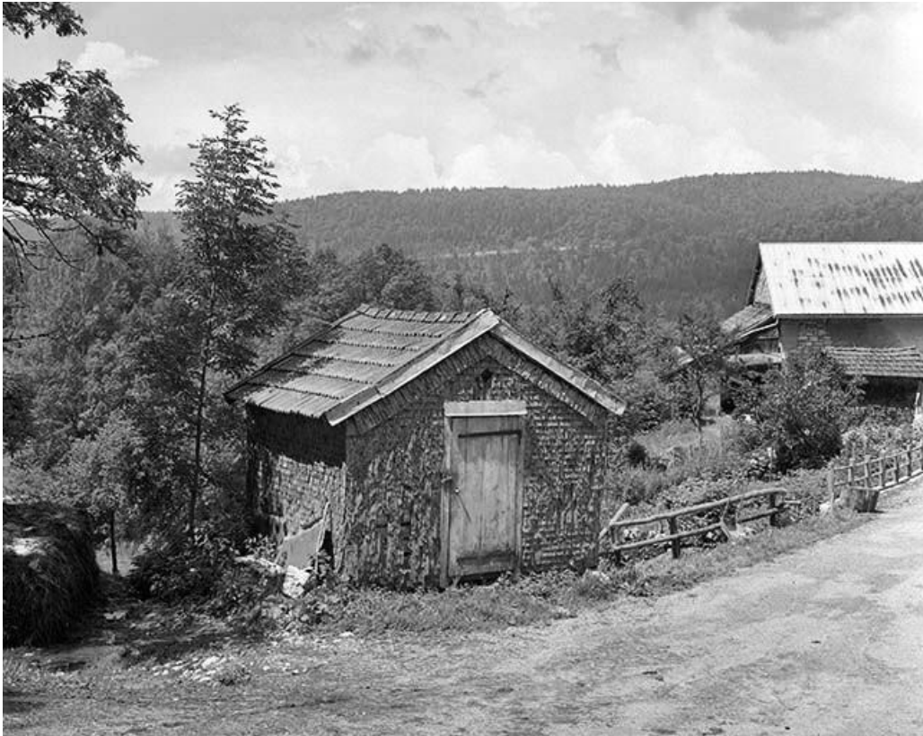
Vue de trois quarts gauche du " grenier fort ".
