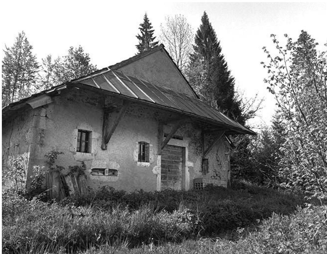
Façade antérieure vue de trois quarts.
