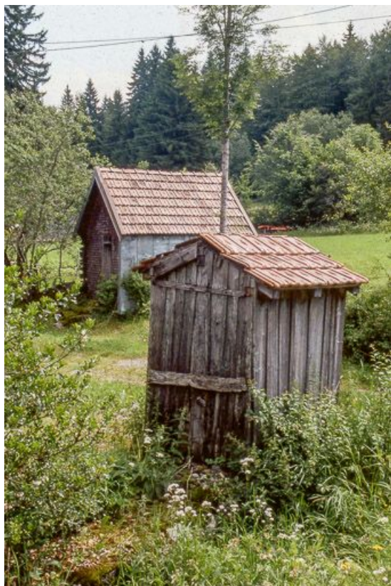
Resserre appelée "grenier fort", vue éloignée.
