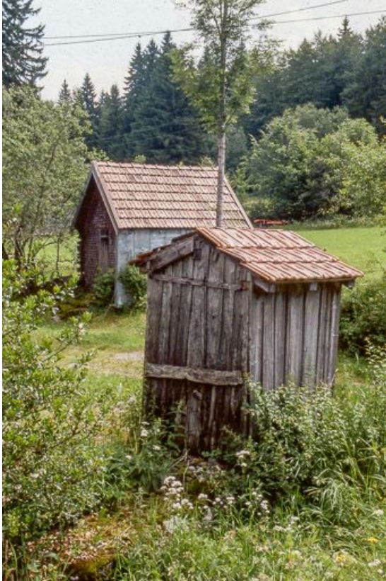
Resserre appelée "grenier fort", vue éloignée.
