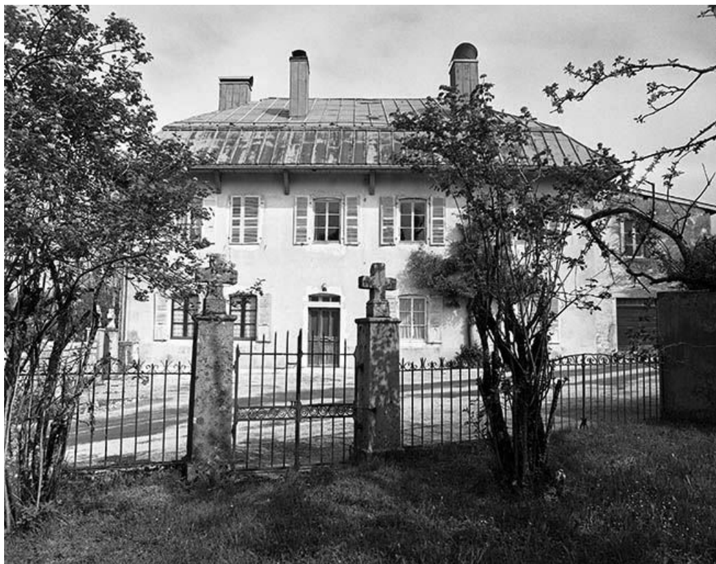
Façade antérieure vue depuis le jardin.
