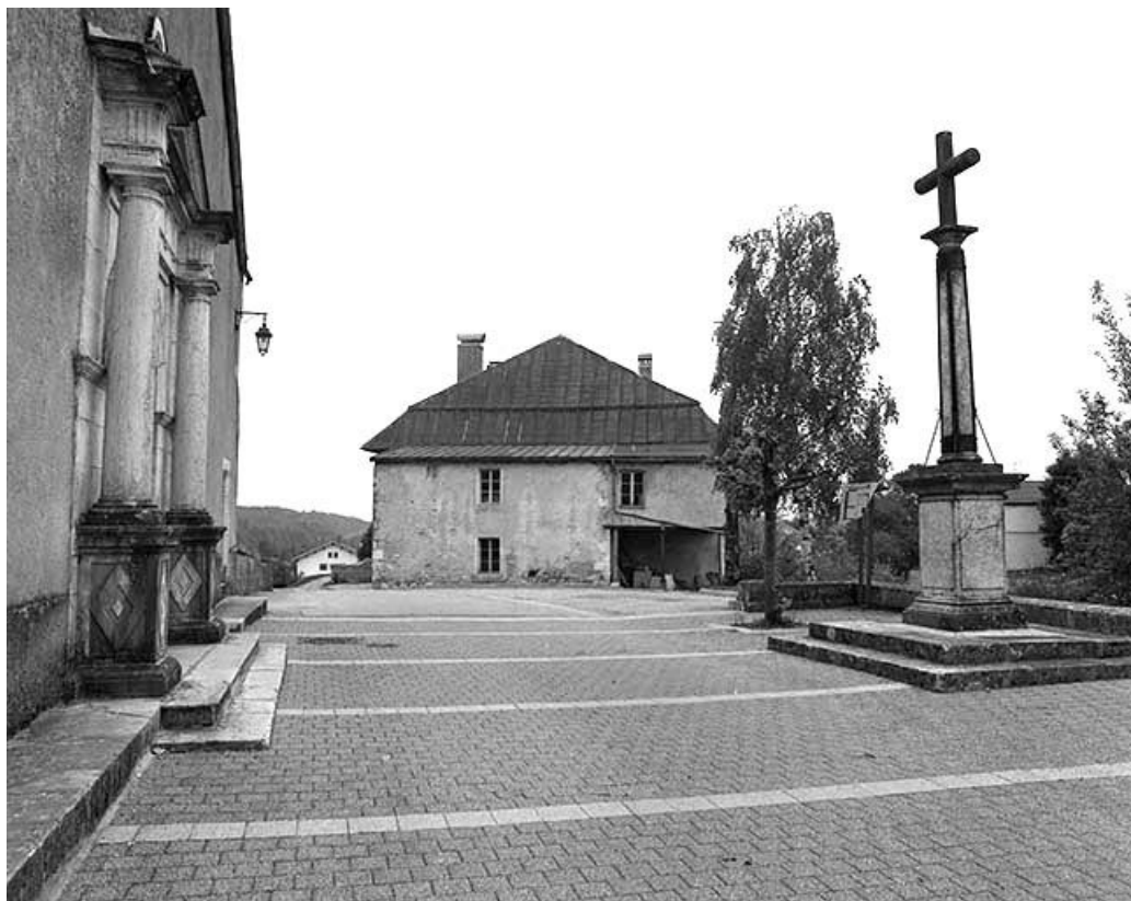
Face droite vue depuis le parvis de l'église.
