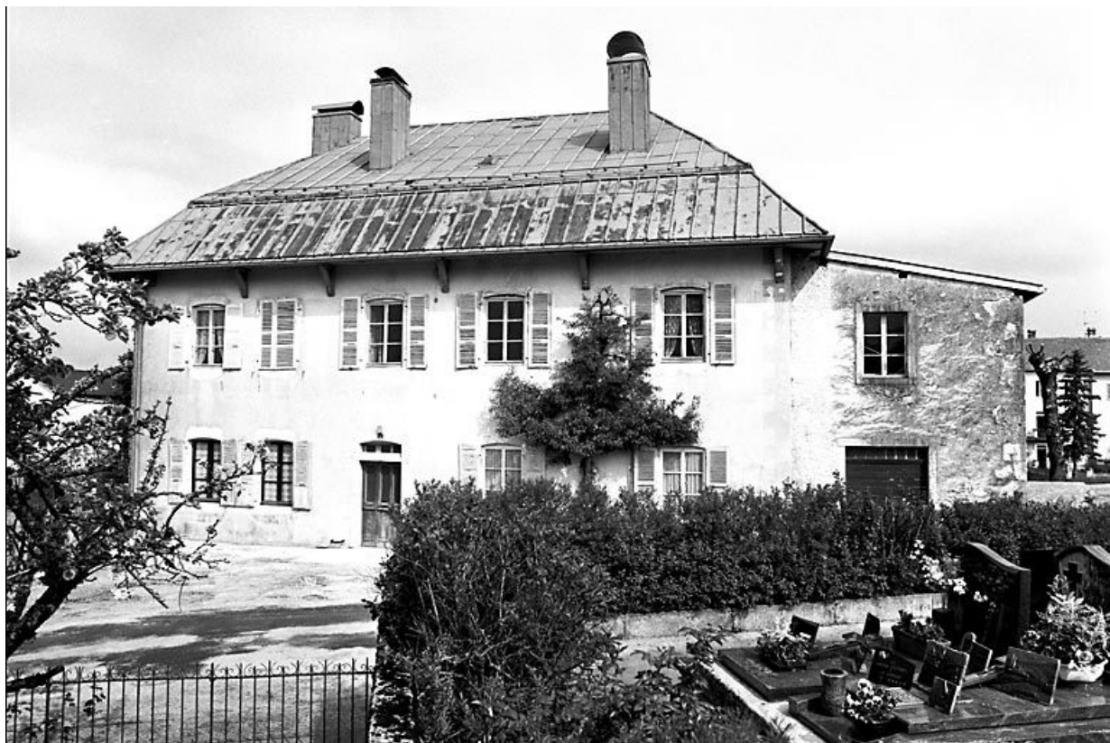
Façade antérieure vue depuis le cimetière.
