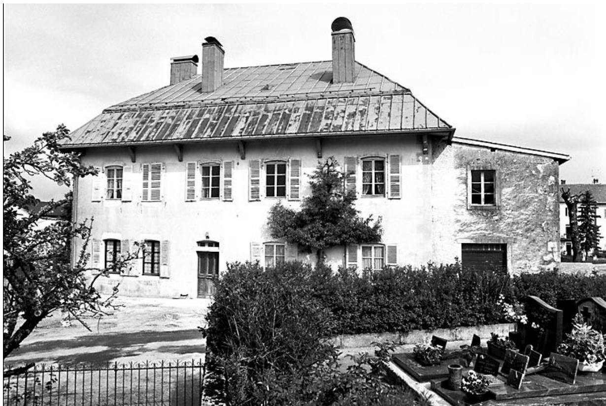
Façade antérieure vue depuis le cimetière.
