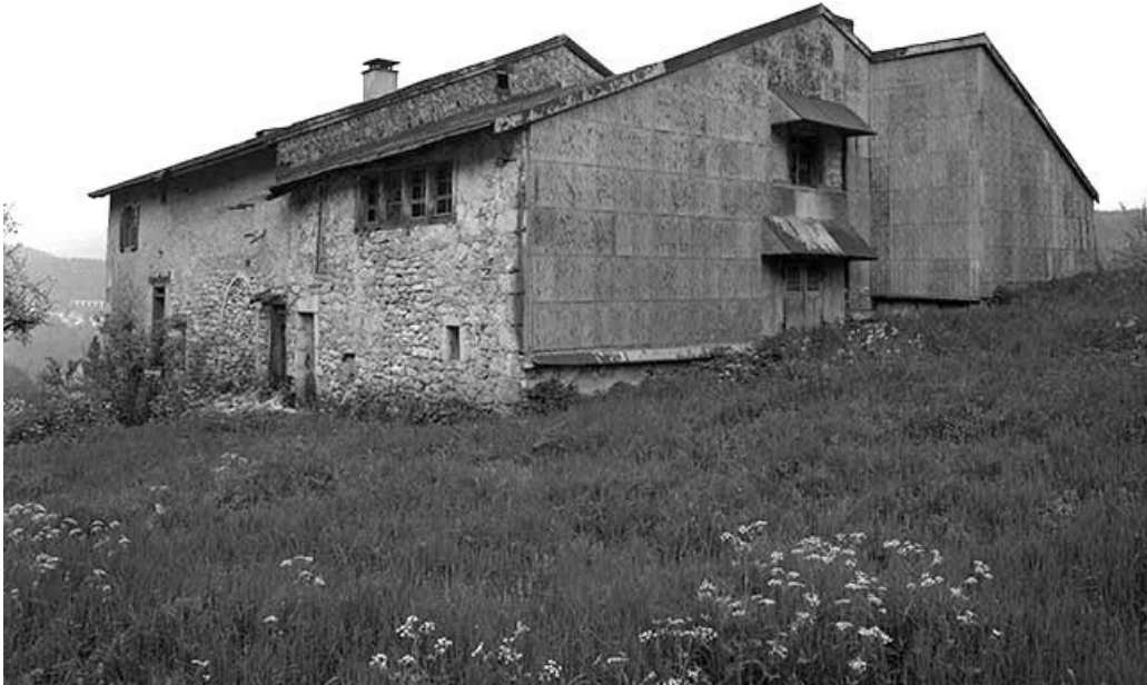
Face gauche et façade postérieure.
