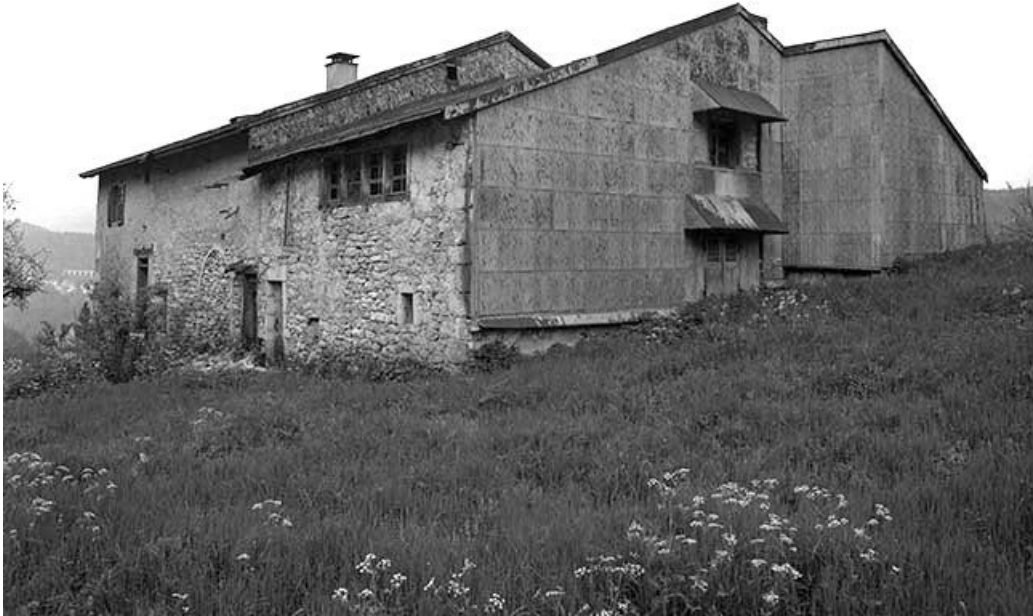
Face gauche et façade postérieure.
