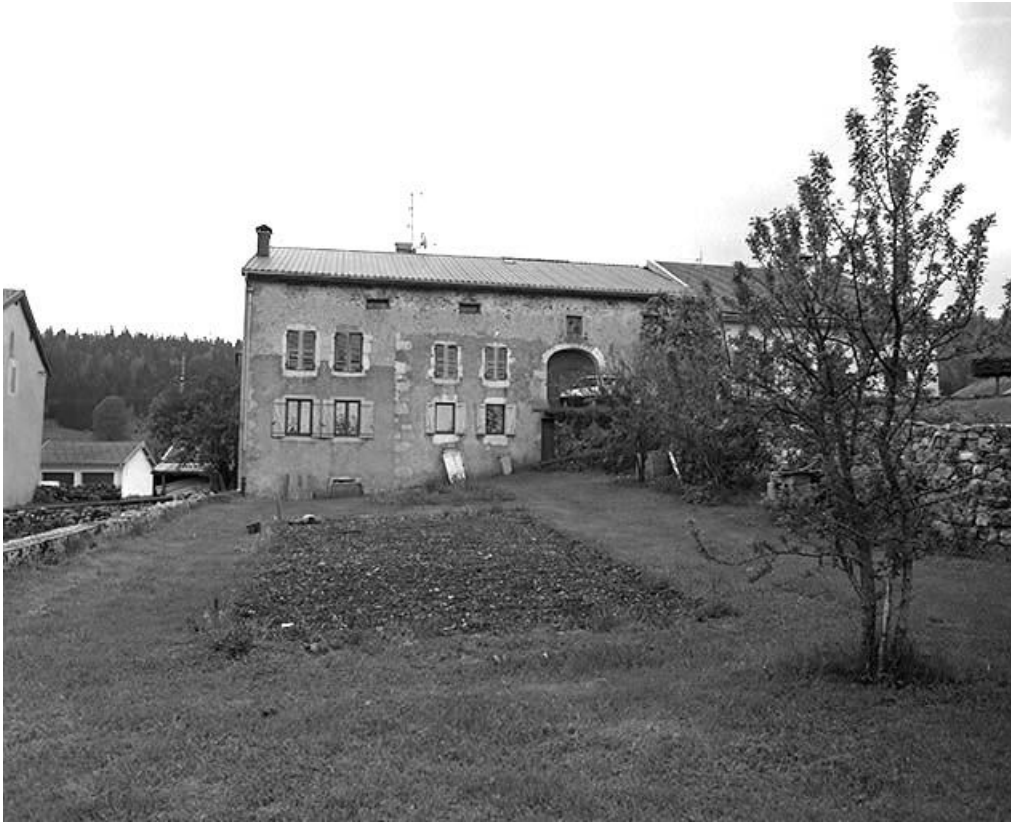
Façade antérieure, vue éloignée.
